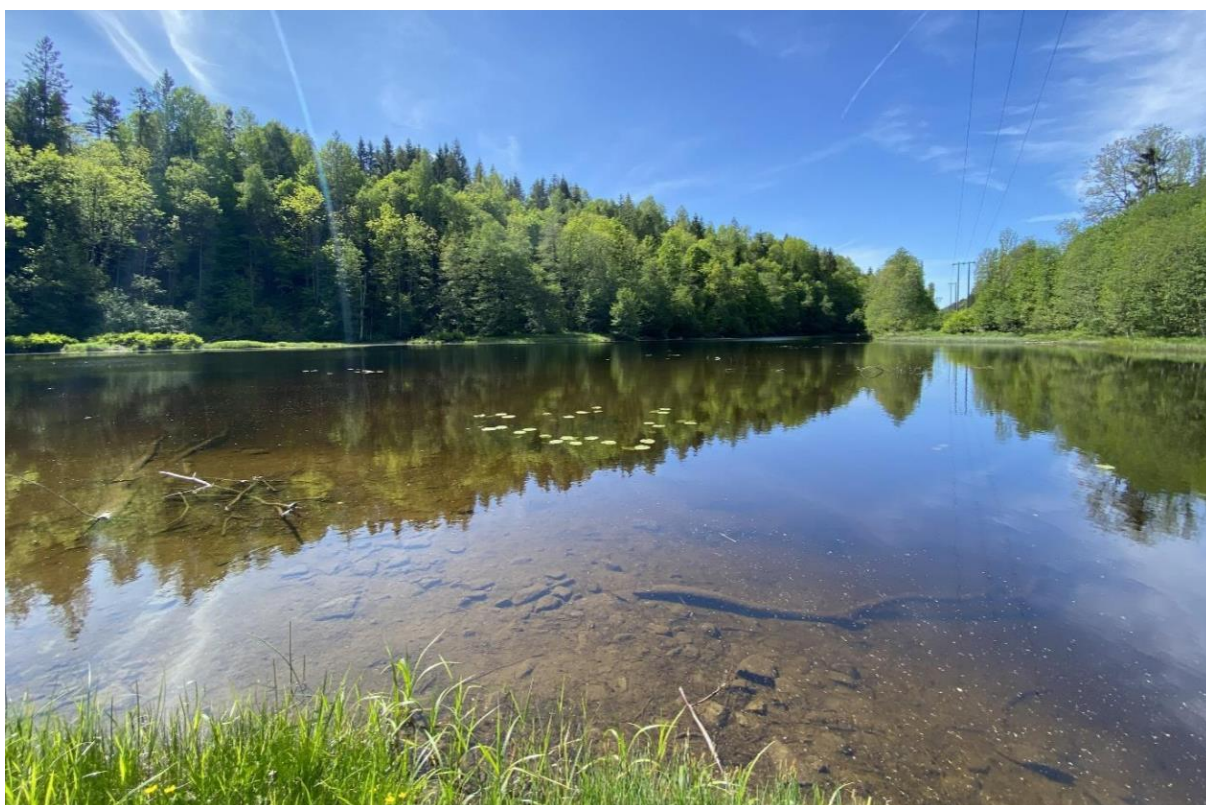
Figur 8-13: Storelva oppstrøms Fosstveit kraftverk der alternativ 30 og 40 krysser i bru. Storelva tilhører vannområdet Storelva inkludert bekkefelt. Brufundamenter vil plasseres på liten holme helt til venstre i bildet. (Kilde: Sweco).
