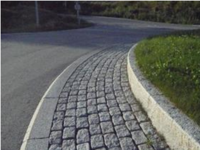
Figur 2-17 Eksempel på overkjørbart areal med storgatestein
