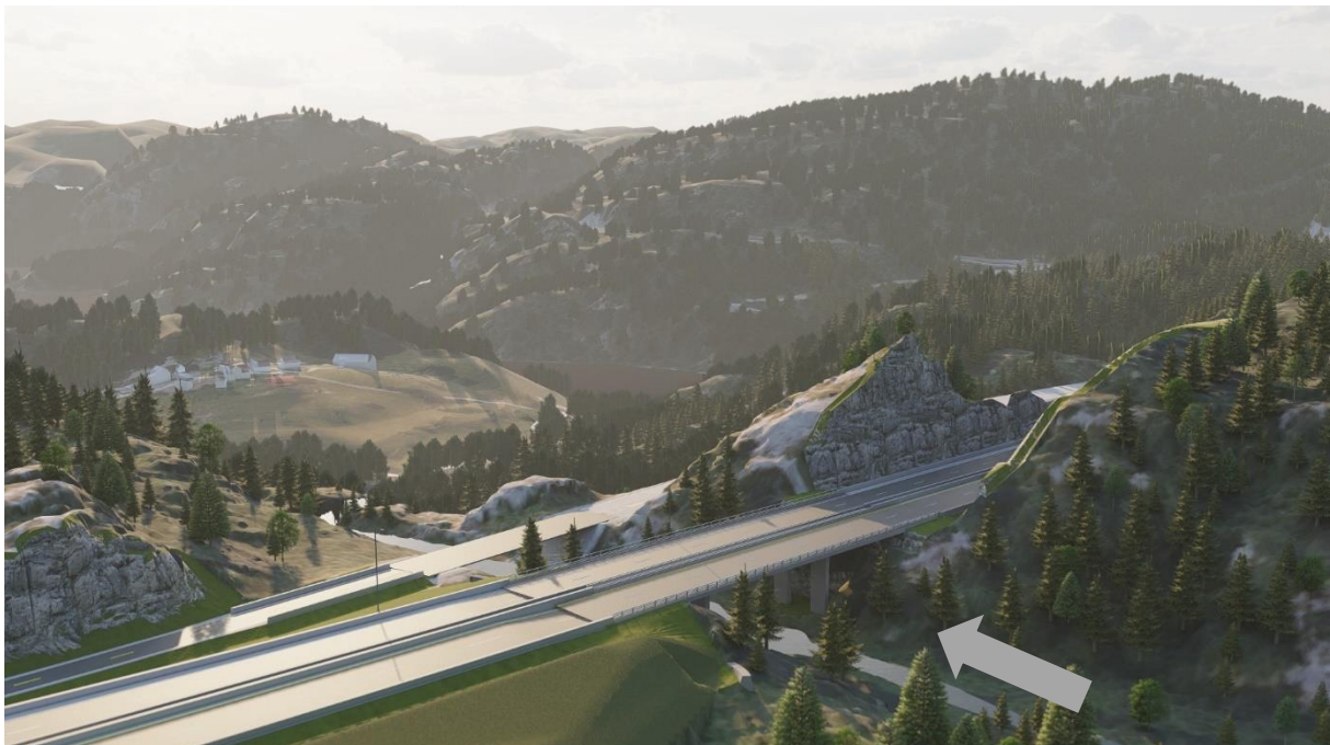
Figur 5-6: Det er tilrettelagt for at vilt kan passere under ny Storfossen bru langs Avkomsttjønna, mellom brusøylene på begge sider av elva (grå pil).
