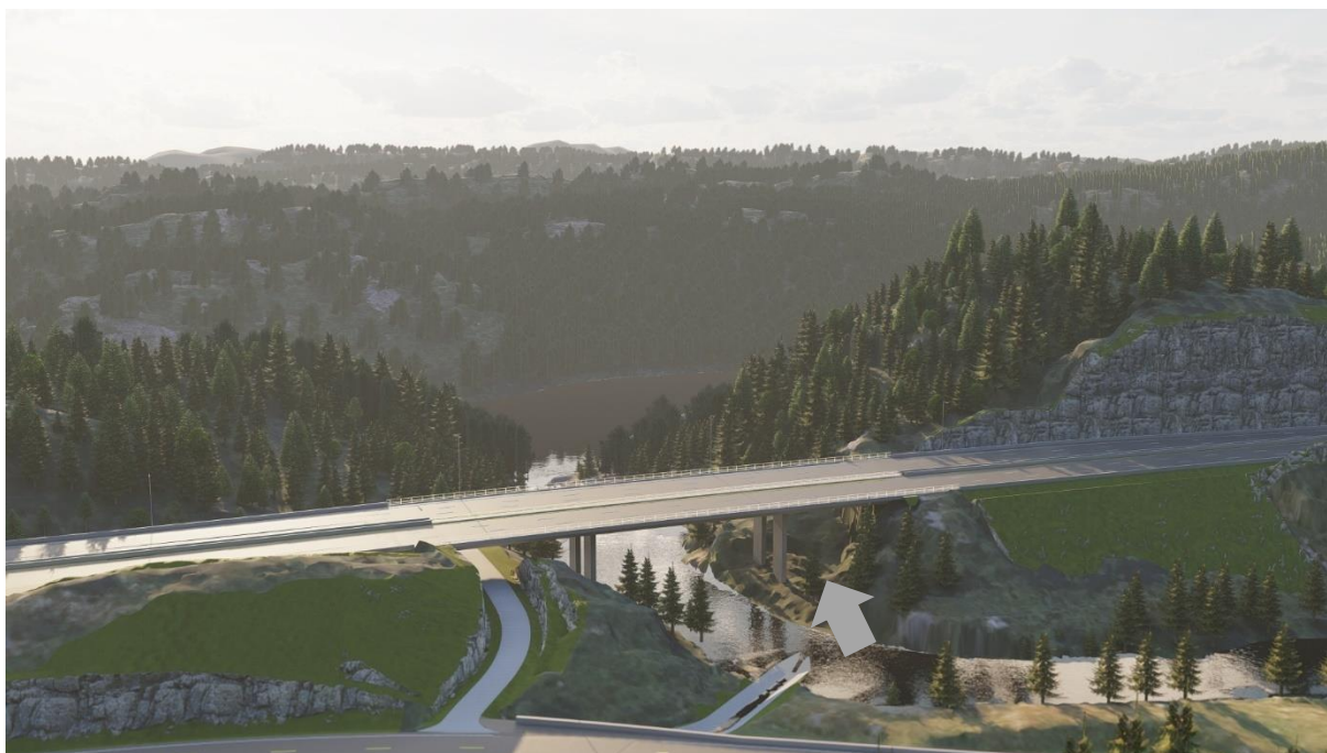
Figur 5-8: Det er tilrettelagt for at vilt kan passere under Frøitlandsfossen bru, mellom brusøyle og sideterreng / landkar nord for elva (grå pil).
