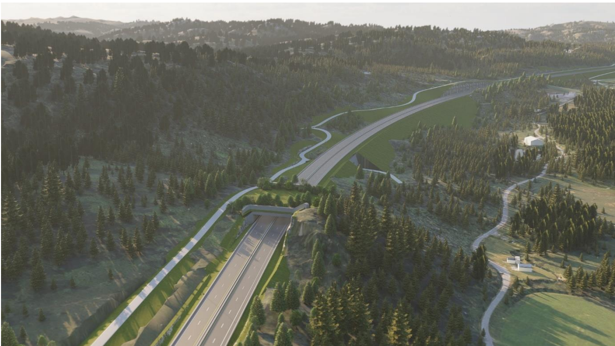
Figur 5-3: Høylandsdalen faunapassasje er prosjektert midt i Høylandsdalen. Illustrasjonen viser passasjen sett fra nord (øverst) og øst (nederst).
