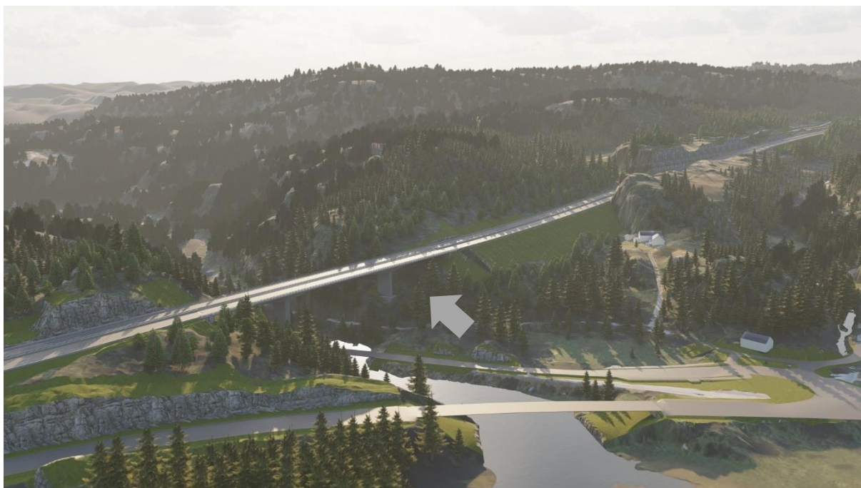
Figur 5-2: Det er tilrettelagt for at vilt kan passere langs vestsiden av Møska, under Røyskår bru mellom brusøyle og sideterreng / landkar (grå pil).
