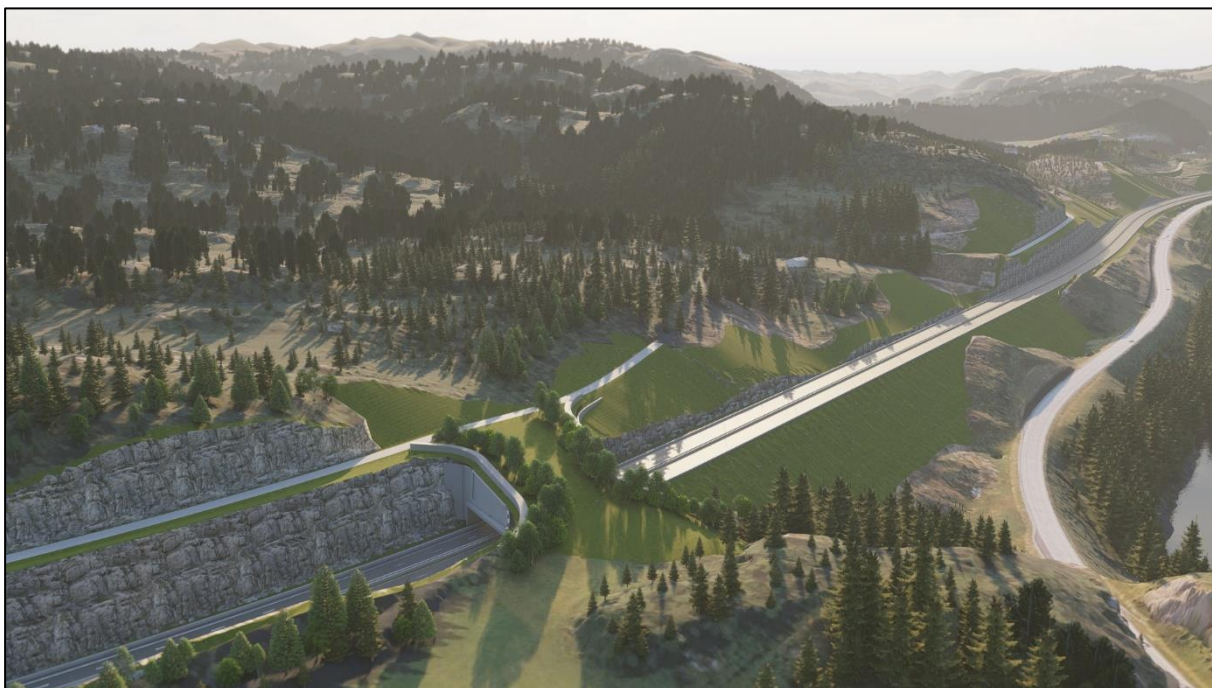
Figur 3-20 K120 Lyngåsen faunapassasje sett fra øst.
