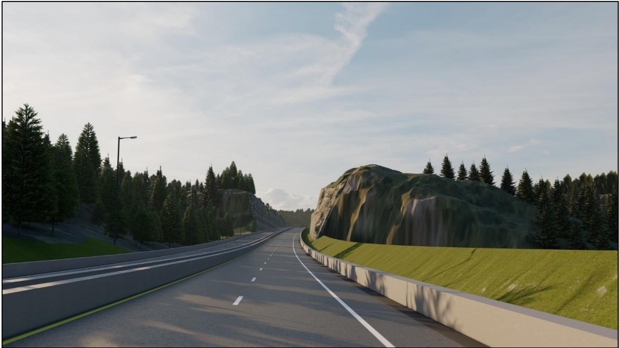
Figur 3-32 Voll langs ny E39 skjermer for innsyn og støy.
