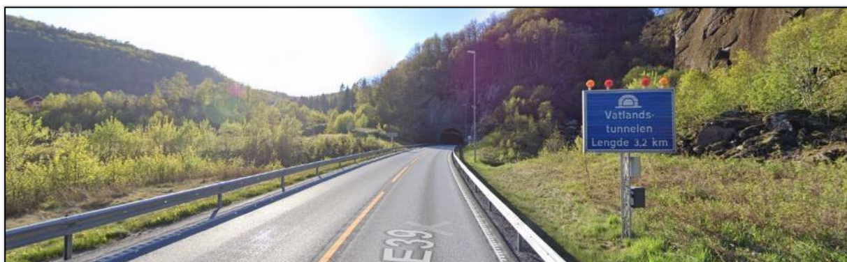
Figur 2-7 Vatlandstunnelen ved Rørdal. (Kilde: Google Maps)
