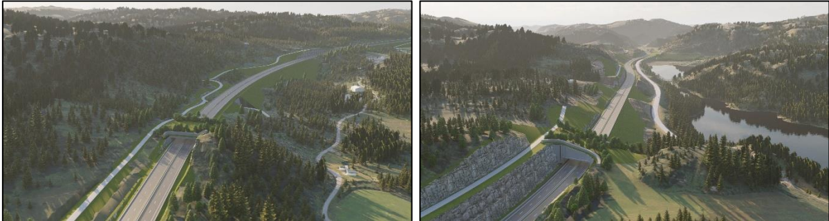
Figur 3-8 Til venstre: Faunapassasje sørvest for Hoggfjell. Til høyre: faunapassasje ved Lyngåsen.
