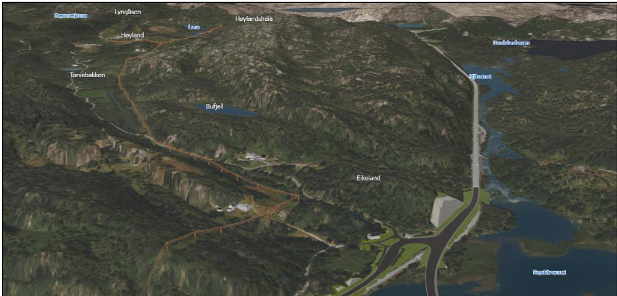
Figur 2-3 Høylandsheia mellom dagens E39 og Høylandsdalen, samt pågående byggeprosjekt på Røyskår.
