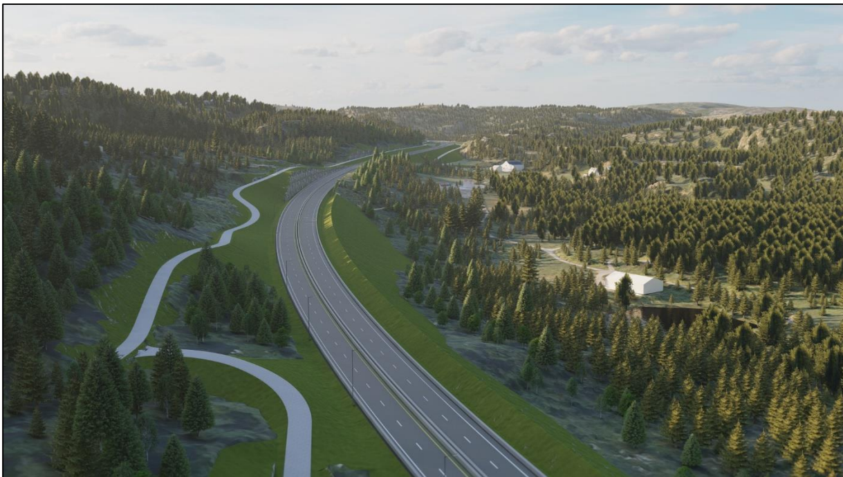
Figur 3-7 Støyskjermende voller langs ny E39.
