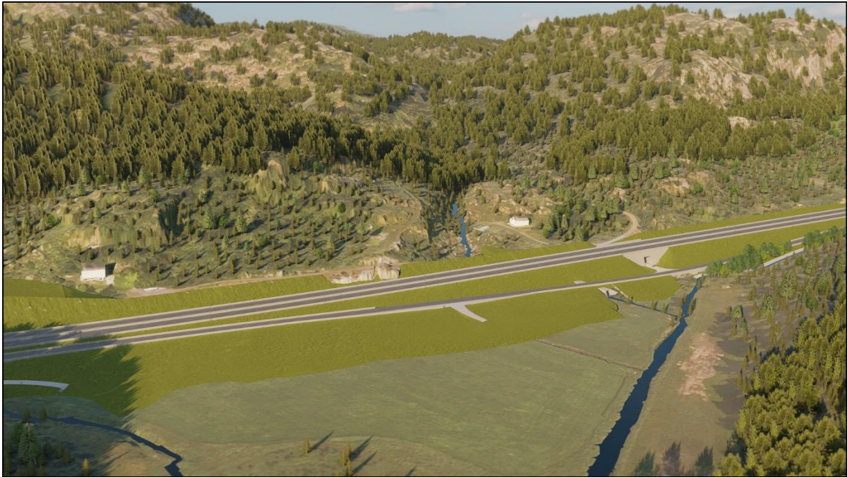
Figur 3-36 Veiskråningen på Steggan reetableres med permanent beslaglagt matjord.
