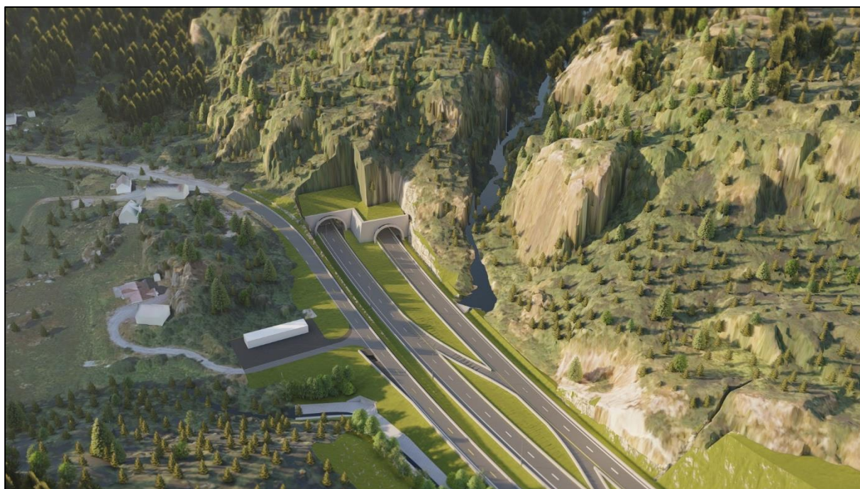
Figur 3-17 Nytt tunnellop etableres sør for dagens tunnel.
