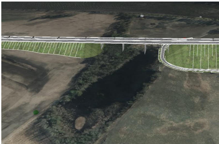
Figur 5-38 Bru over Gammelelva ved Hovin ferdig bygget. Sett fra vest mot øst
