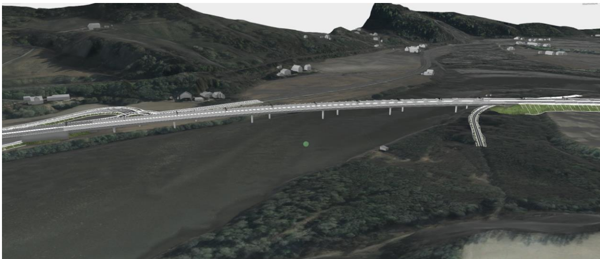
Figur 5-43 Kåsabruene i ferdig tilstand, sett fra vest mot øst. Kilde: Norconsult.
