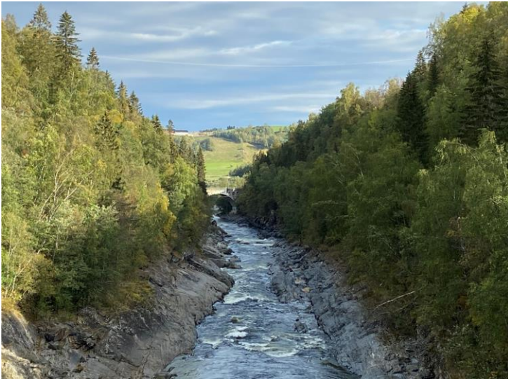
Figur 3-2: Bilde tatt fra Gaulfossbrua som viser juvet ved Gaulfossen.
