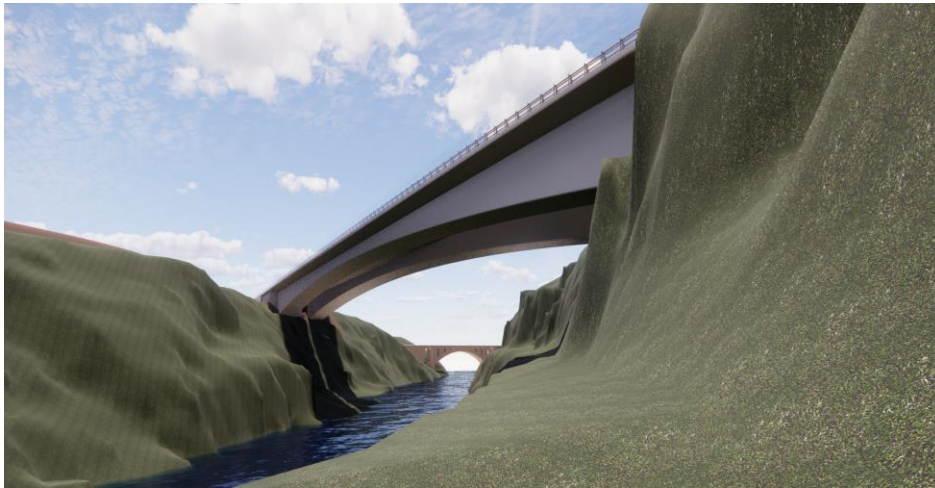
Figur 5-40 Gaulfossbruene ferdig bygd, sett fra vannkanten i Gaula
