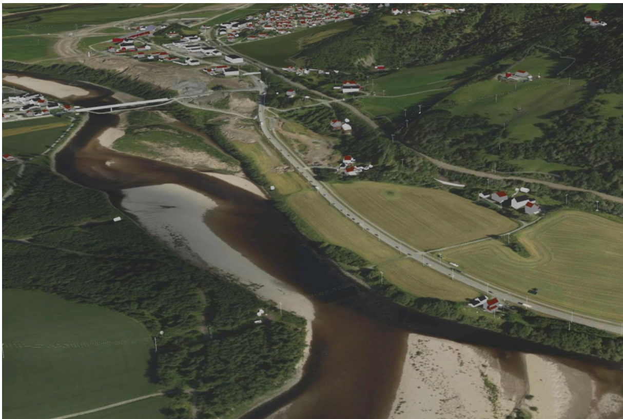
Figur 3-9: Dagens E6 sør for Kvål, Gammelvelva naturreservat nederst til høyre i bildet, bygging av E6 Kvål – Melhus øverst til vestre i bildet. Bilde hentet fra: 3d.kommunekart.com.
