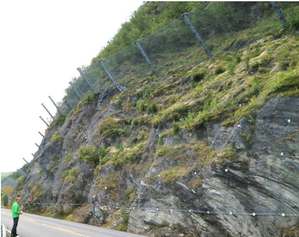
Figur 2-2. Det er gjort omfattende arbeid med steinsprangsikring over traseen.
