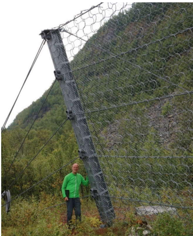
Figur 2-3. Gjerdet i østre ende med 5 meters høyde og 3000 kJ energikapasitet.
