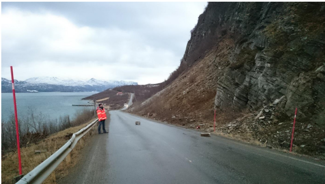
Figur 2-4. Eksempel på nedfall som har forekommet langs veien. Bilde fra SVV rapport nr. 2013031895-34.
