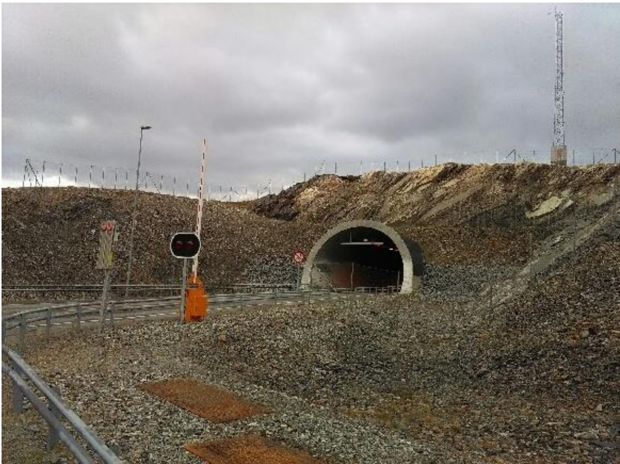
Figur 27. Ferist og sikringsgjerde riksveg 64. Oversiktsbilde. Foto: Aslak Ante M Sara
