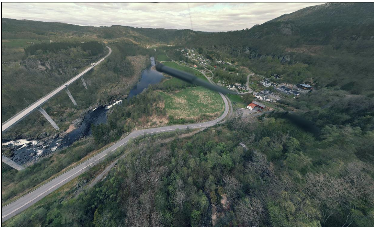
Figur 7-23: Dronebildet tatt fra nordsiden av Refstiheia. Fedaelva er sentralt element i delområdet.
