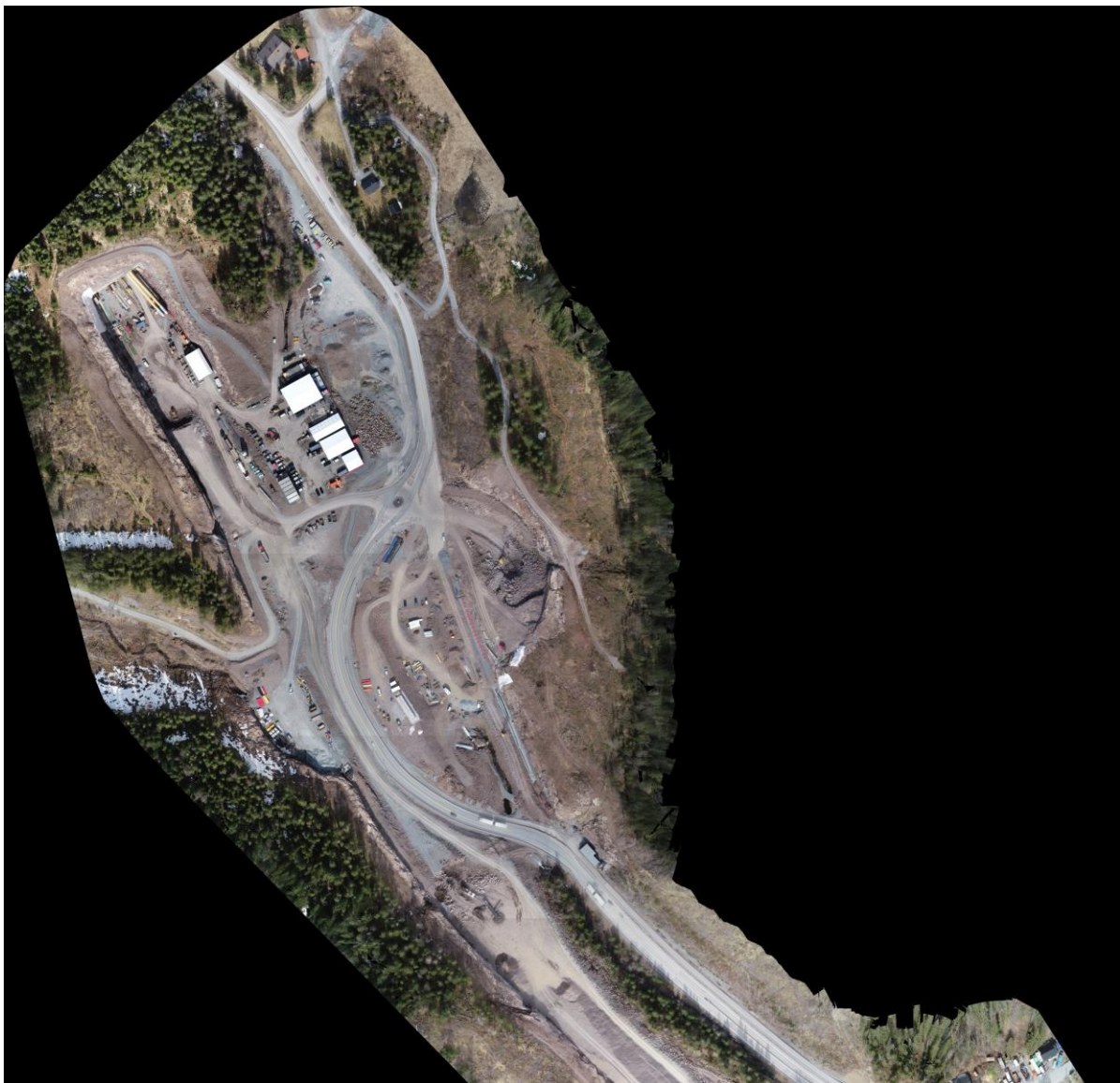
Figur 2: Avtjerna. Ny E16 er under bygging. Eksisterende E16 er omlagt og det er etablert en midlertidig rundkjøring for atkomst mot anleggsområdet og skogsområdene i vest. Dronebildet er tatt 21.04.2022.
