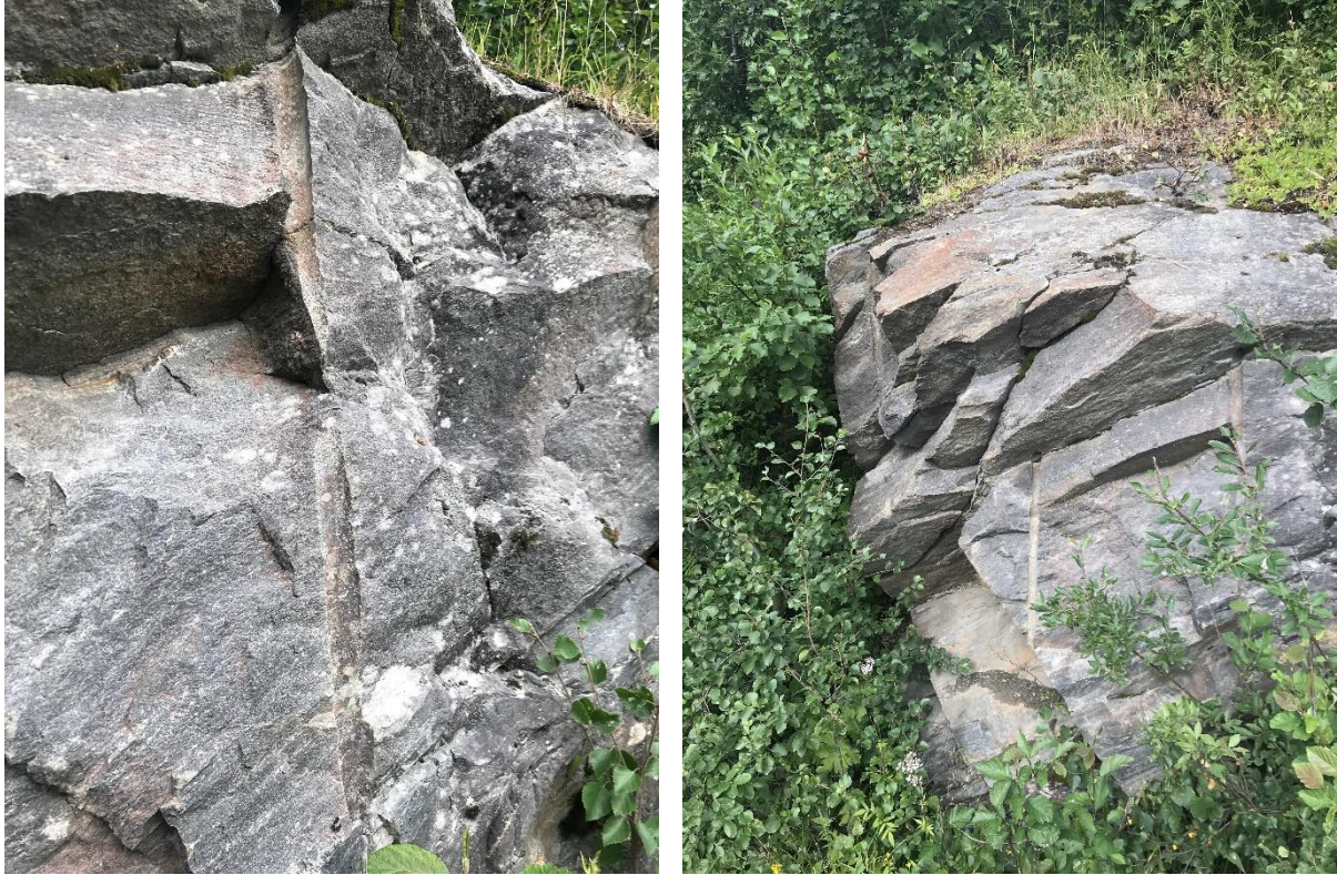
Figur 24: Bilder av bergarter som det er målt sprekkeorienteringer i ved påhugg øst. Bildene viser kartlagte bergskjæringer langs eksisterende E6.
