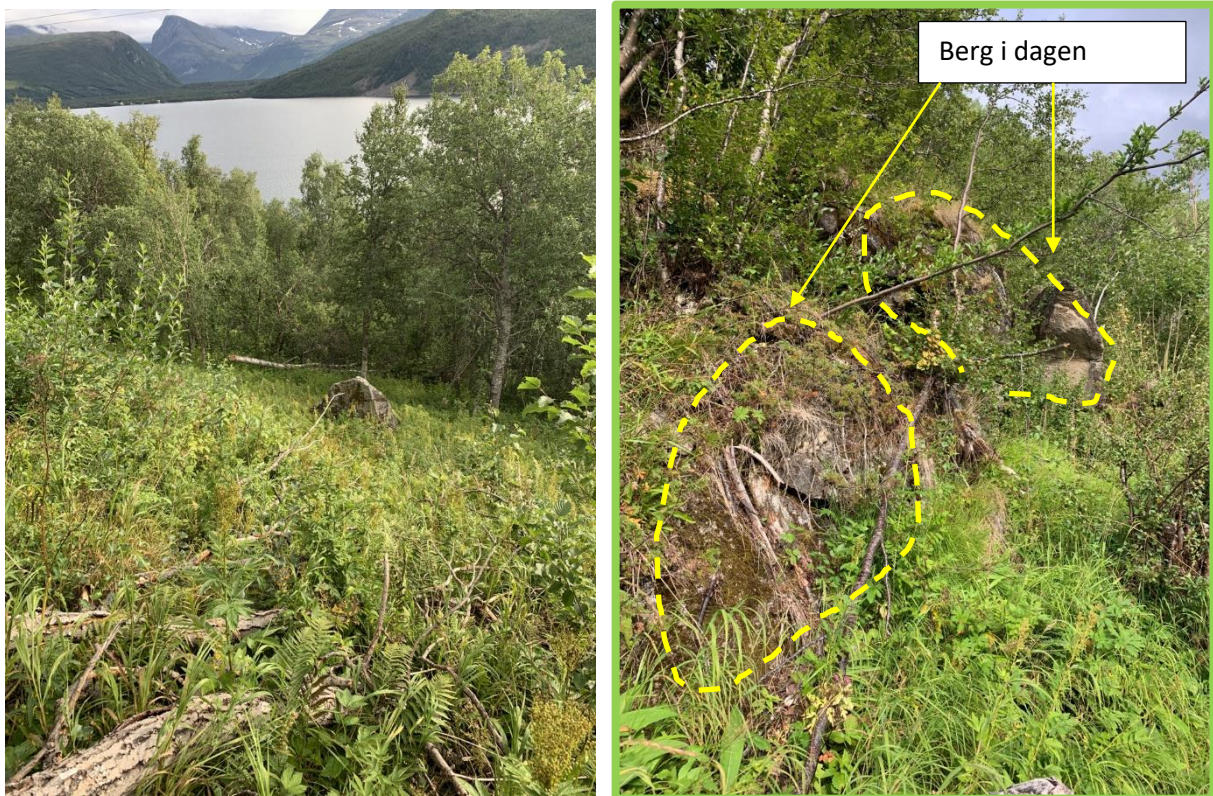
Figur 19: Oversiktsbilder for påhugg vest for Mettevolltunnelen. T.v: Blokk nedenfor bergnabb. T.h: Berg i dagen.
