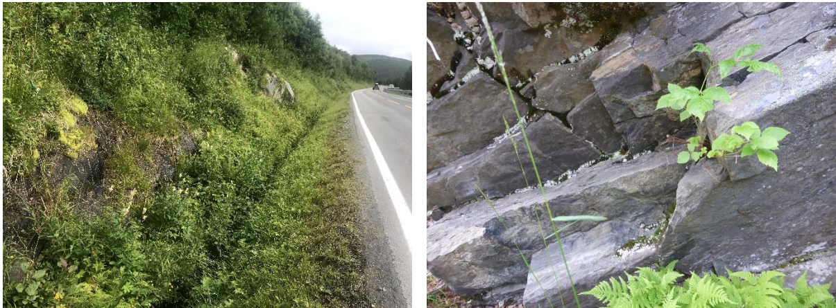
Figur 25: Bilder av bergarter som det er målt sprekkeorienteringer i ved påhugg øst. Bildene viser kartlagte bergskjæringer langs eksisterende E6.
