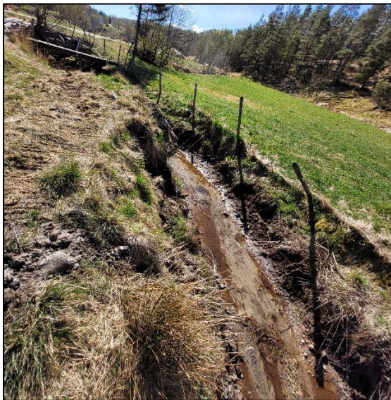
Figur 3-52. Frøylandsbekken sett mot sør. Foto: Sweco, 2022.
