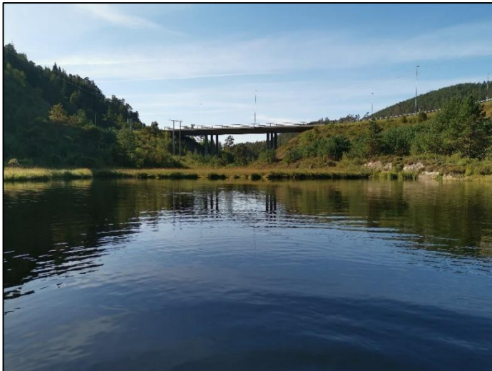
Figur 3-38. Indretjønn sett mot sør. Dagens E39 kan sees i bru i bakgrunnen. Foto: Sweco 2022.
