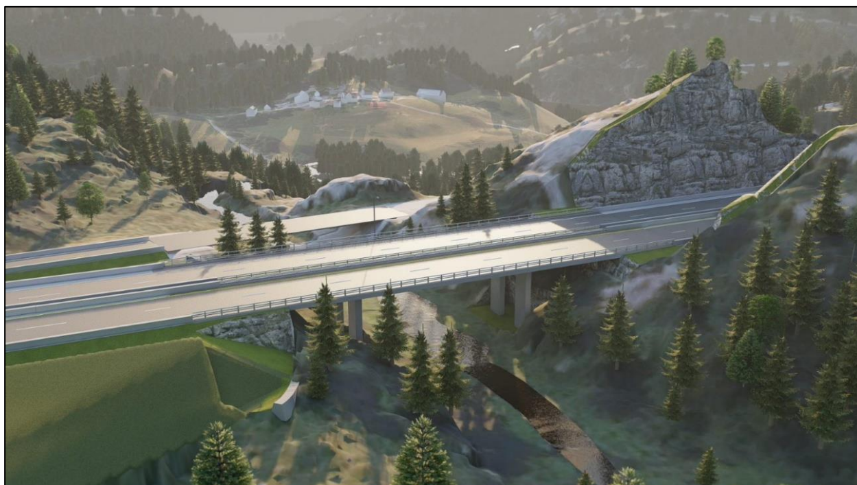
Figur 3-25. Storfossen bru over Avkomstjønna sett mot Oppofte.
