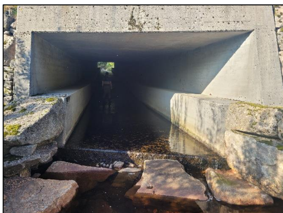
Figur 3-12. Kulvert i Botnebekken under dagens E39. Foto: Sweco, 2022.
