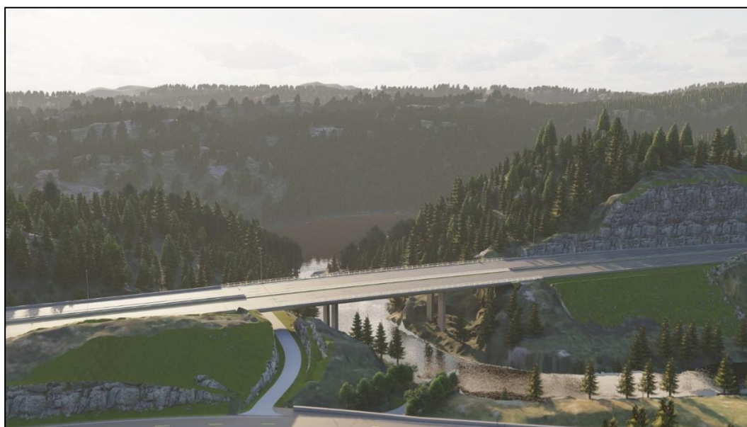
Figur 3-50. Bru over Frøitlandsfossen, sett mot Høylandsbotnen.
