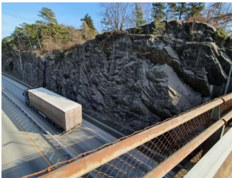
Figur 6-13: Skjæring langs E18 ved befaringslokalitet C001. Ingen sikring, noen synlige borpiper. Bilde tatt mot øst.
