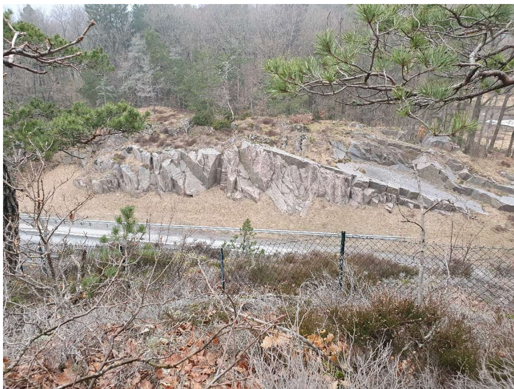
Figur 6-28: Skjæring langs nordsiden av eksisterende E18, tatt fra C005 mot nordvest.
