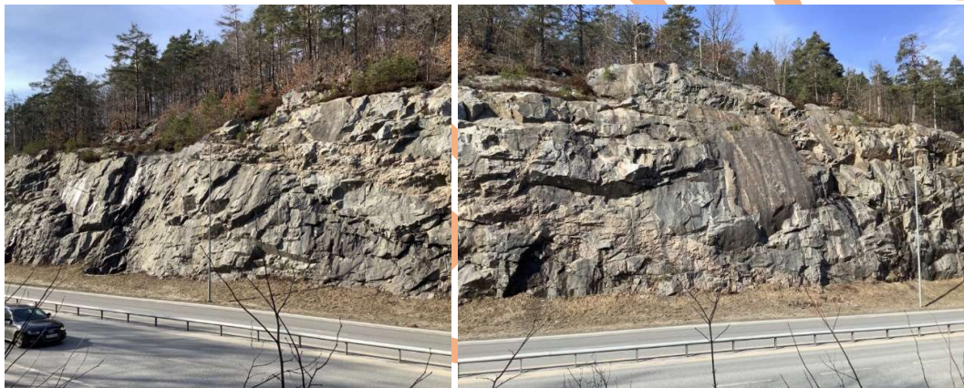
Figur 6-9: Deler av eksisterende skjærings langs E18 mellom S004 og S014.
