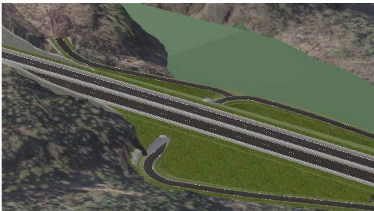
Figur 2.13: K269 Bjønnåsen kulvert sett fra nord
