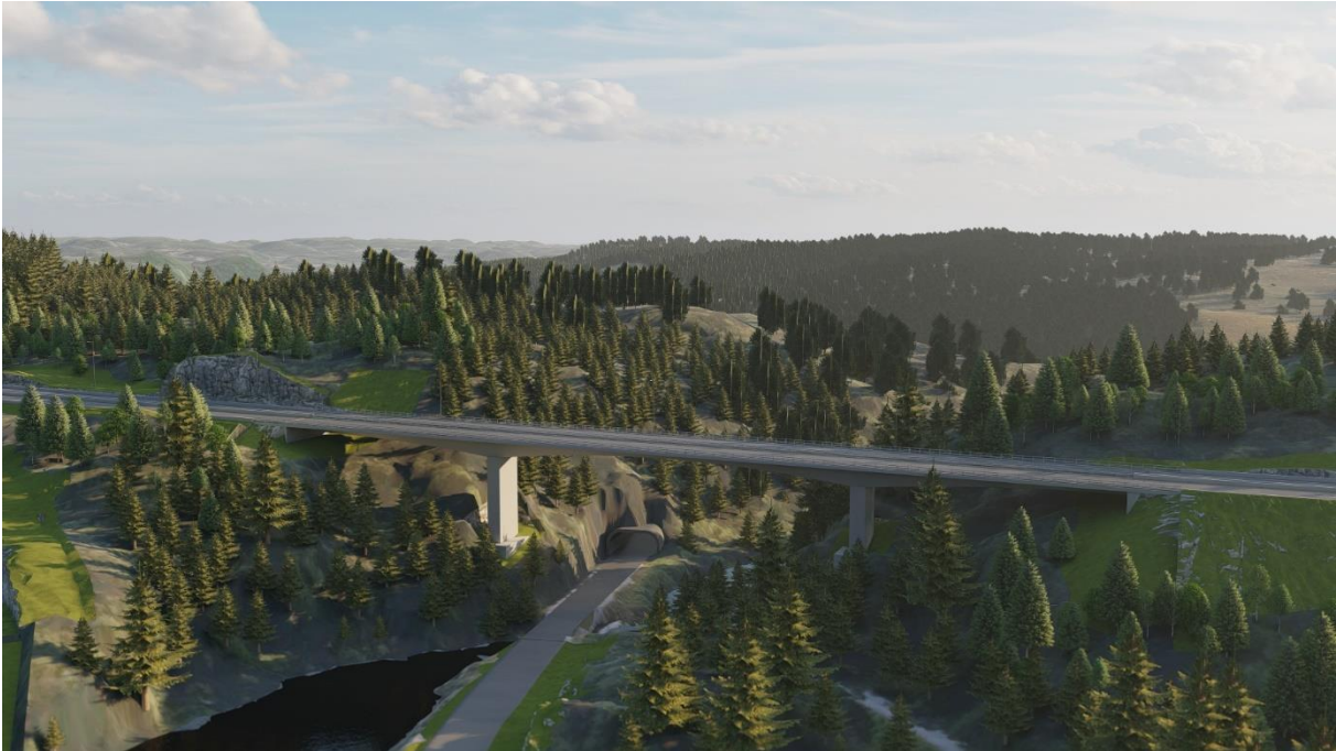
Figur 2-1: K100 Røyskår bru sett fra nord
