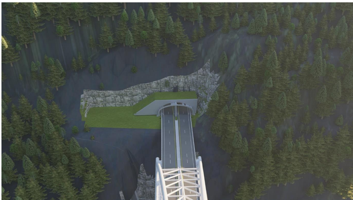
Figur 2-15: K200 Portal Espedal nord sett fra nord
