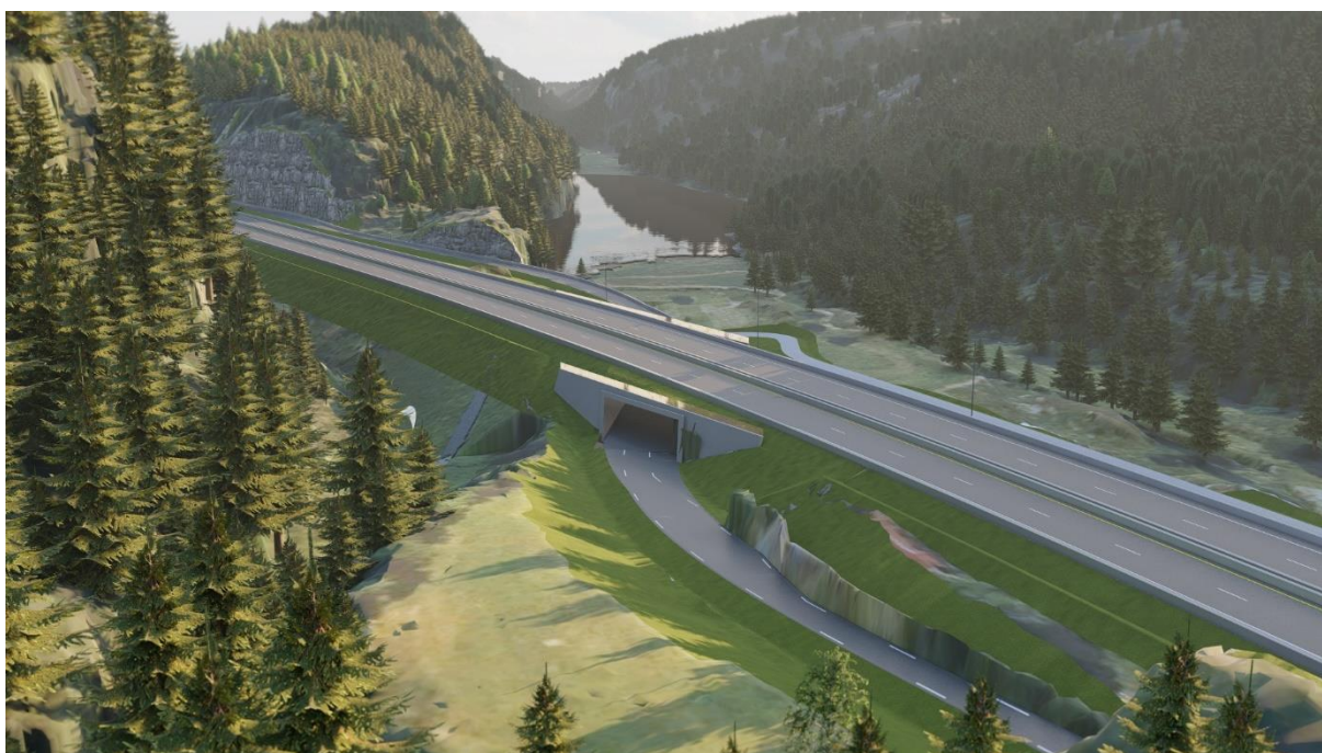
Figur 2.14: K280 Melandsveien kulvert sett fra nord
