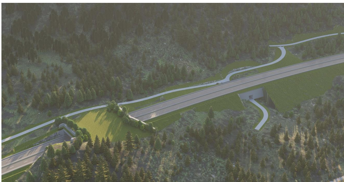
Figur 2-7: K115 Høylandsdalen kulvert sett fra nord
