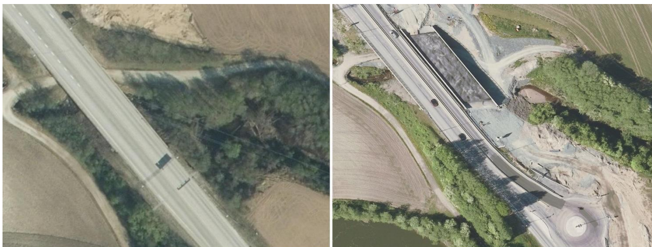
Figur 4-25. Lodbekken før (2019, foto til venstre) og under (2021, foto til høyre) bygging av ny E6 Kvål - Melhus.
