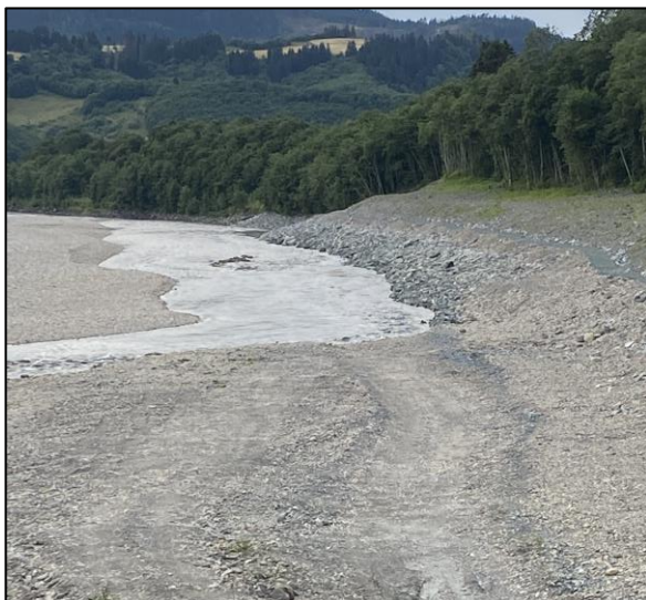
Figur 4-22. Ny erosjonssikring nedstrøms Kvålsbrua ifb. bygging av ny E6 Kvål – Melhus. Foto er tatt på svært lav sommervannføring. Naturlig revegetering over turstien som er etablert midt på fyllingen. Fyllinga er forblenda med naturgrus, men denne har forsvunnet i vårflommen (planlagt). Det er noe erosjon i elveøra på motsatt side.
