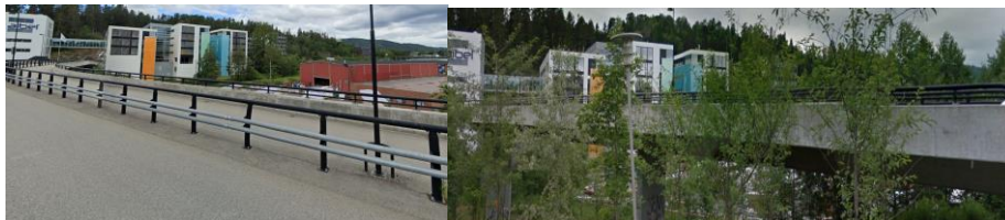
Figur 27; Viser brua mellom nettstasjon 1 og parkeringsplass ved Maxbo.
