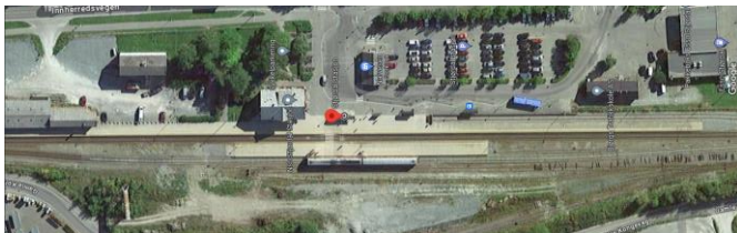
Figur 43; Oversiktsbilde av Stjørdal stasjon.
