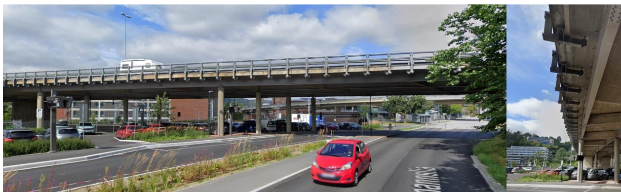
Figur 28; Viser E18 brua fra nettstasjon 4 til parkeringsplass med eget bilde til høyre for undersiden av brua og mulig opphengingsmulighet.
