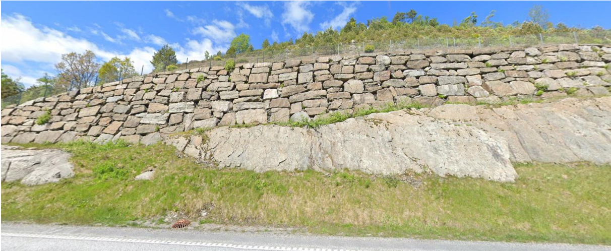
Figur 11: Støttemur ved ca. P6200-6300
