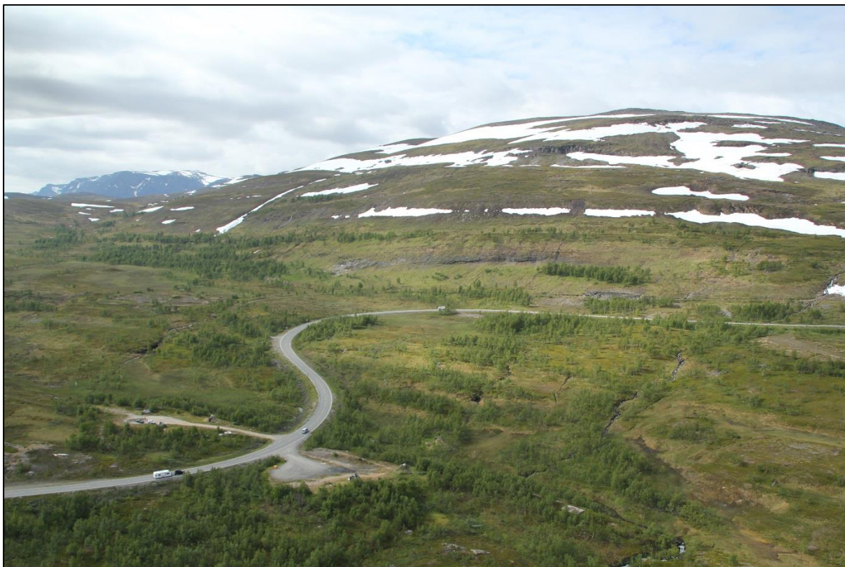
Figur 4. Foto fra helikopterbefaring som viser Storsvingen og østre område for påhugg for tunnel gjennom Malingsfjellet (Foto: O.A. Helgaas, SVV).
