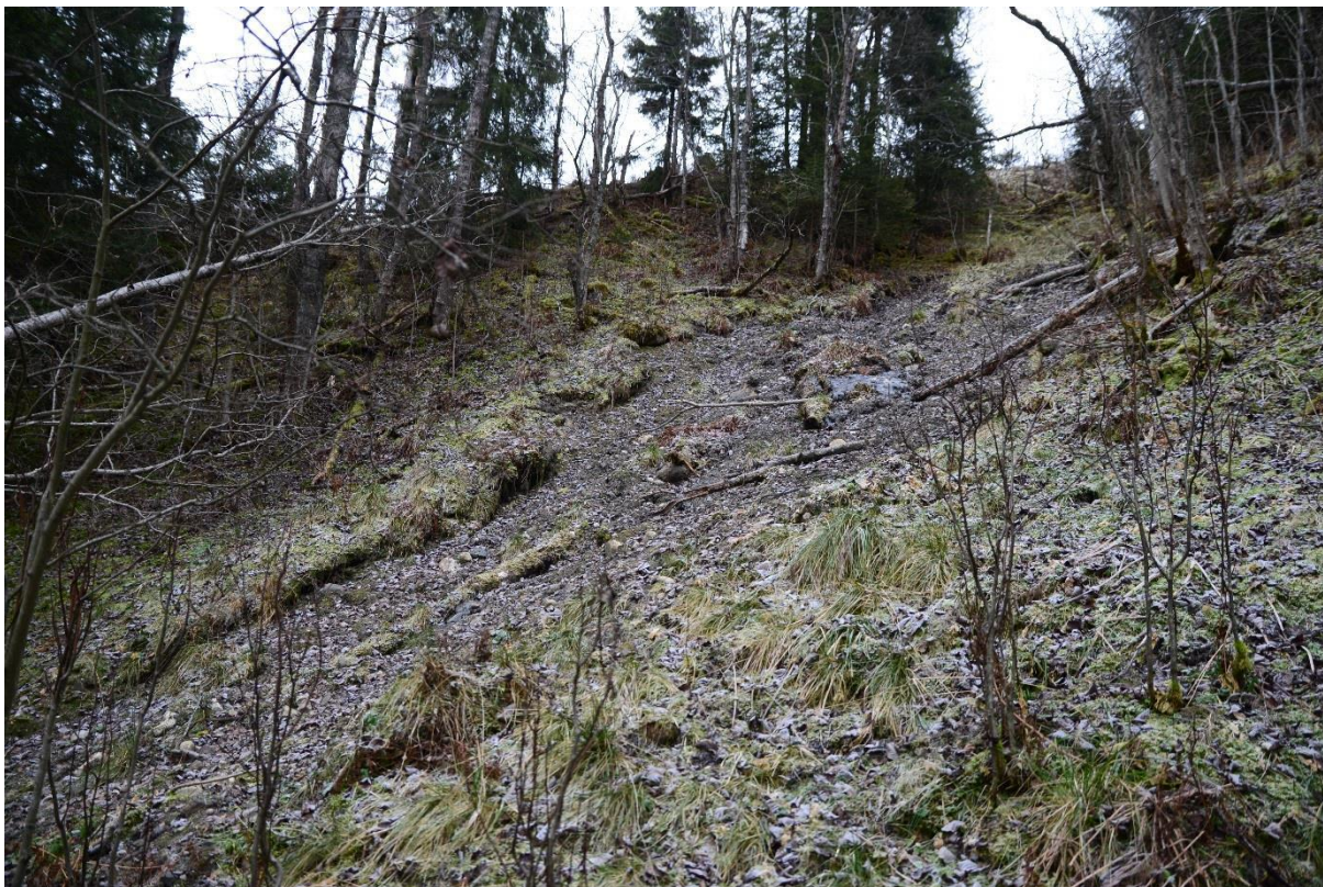
Figur 36 Eldre grunn utglidning i sideterrenget over profil 35000 (Foto fra Swecos rapport [11]).
