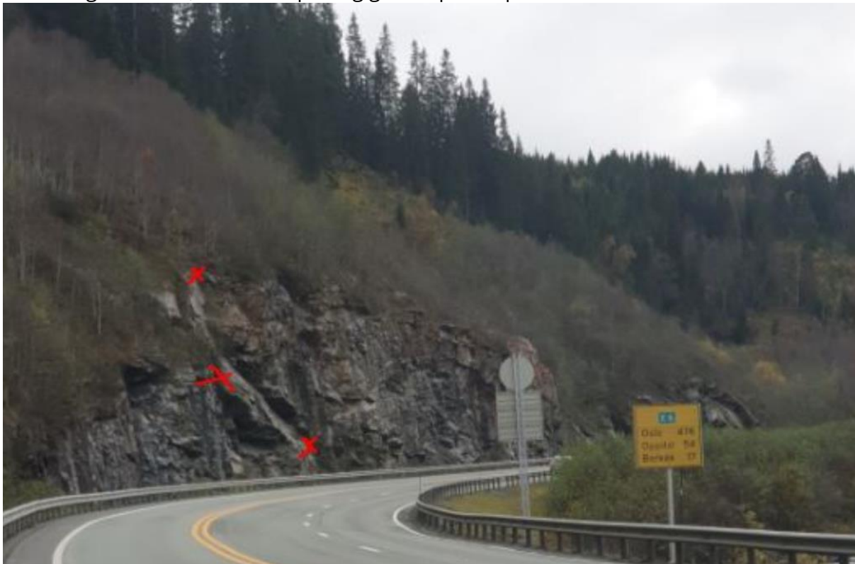
Figur 28 Sprekkeplan 4 med steilt fall ut av eksisterende skjæring.
