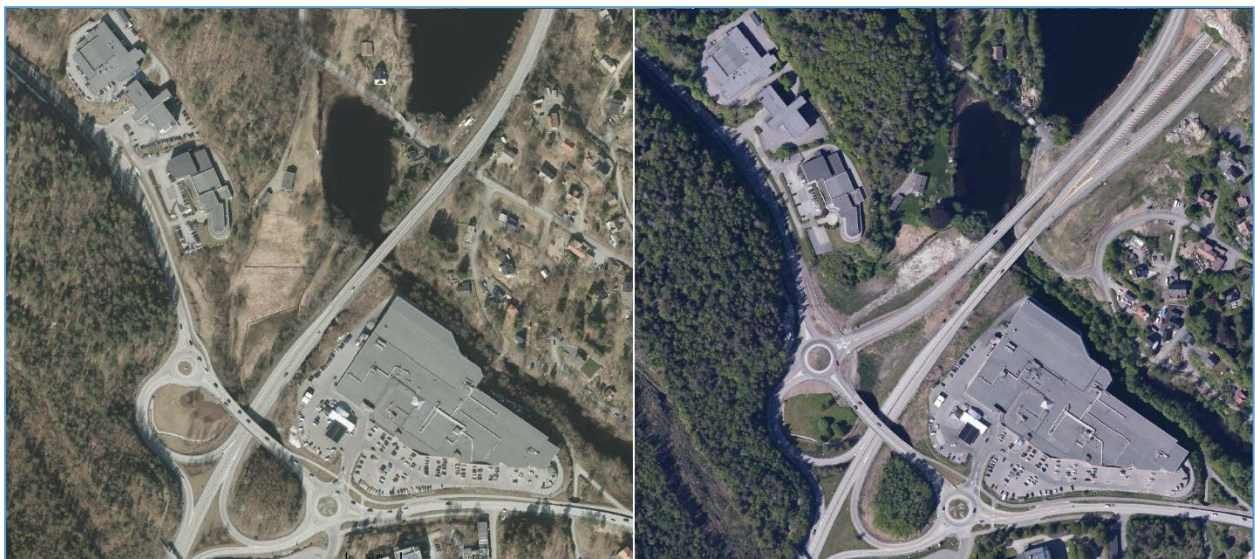
Figur 3-4: Harebakken i 2015 (t.v.) og 2021 (t.h.) med ny E18 i tunnel
