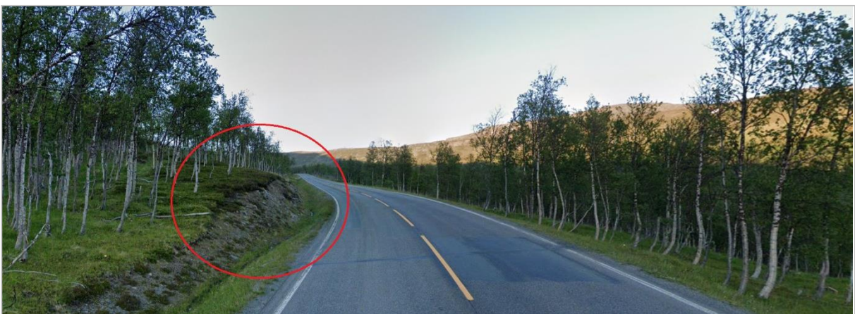
Figur 12: Eksisterende veg mellom profil 7230 og 8400, lav skjæring nær vegen.
