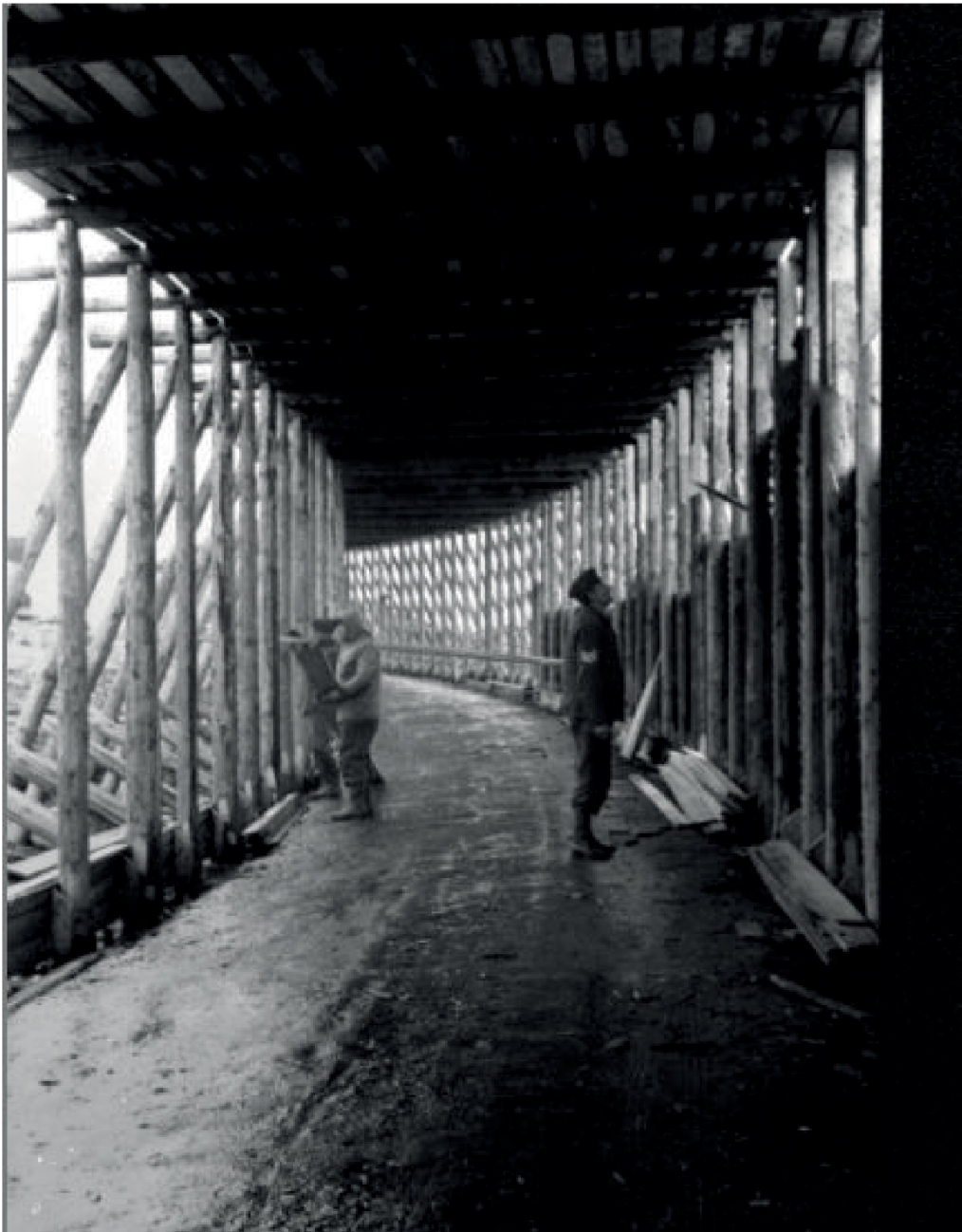
Bygging av snøtunnel
