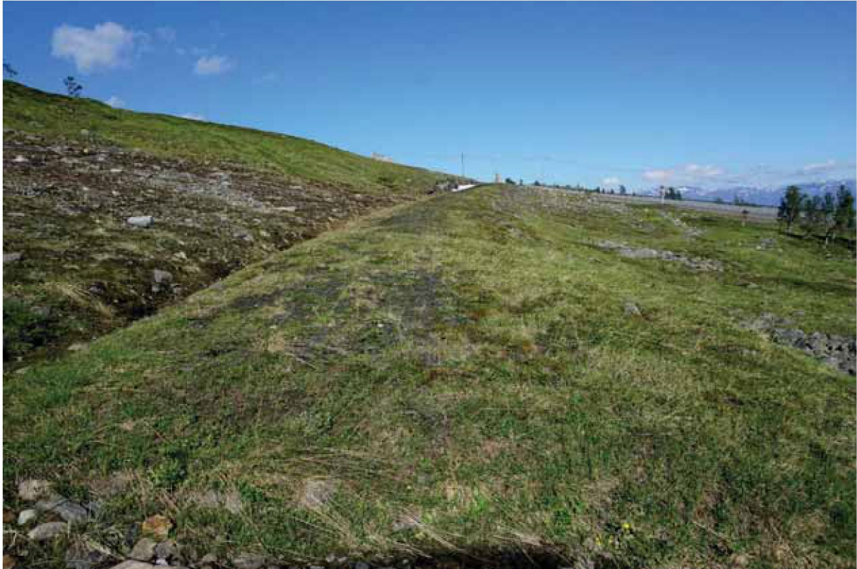
Figur 10: Den gamle riksvegen opp mot Gildetun. Stolpefundamenteringen for snøtunellen er fortsatt tydelig på hver side av veien. Denne delen av riksvegen med stikkrenner bør være en hensynssone.
