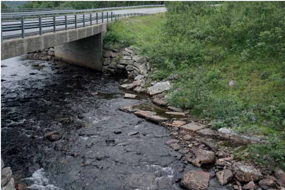
Figur 27: Brukar. Gjenværende del og gjenbruk av stein i brokar ved Sandneselvbrua.
