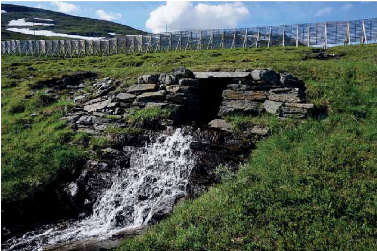
Figur 26: Tørrmurt stikkrenne
