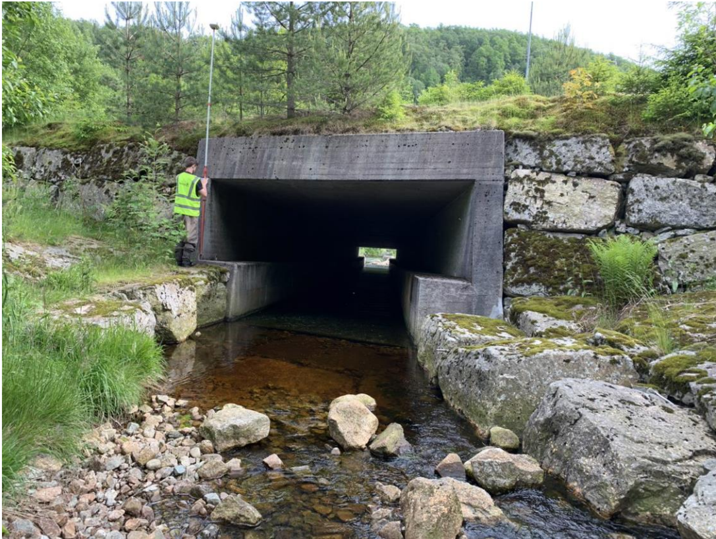
Figur 8-3: Innløp kulvert/bru veiprofil 6660 Botnebekken.
