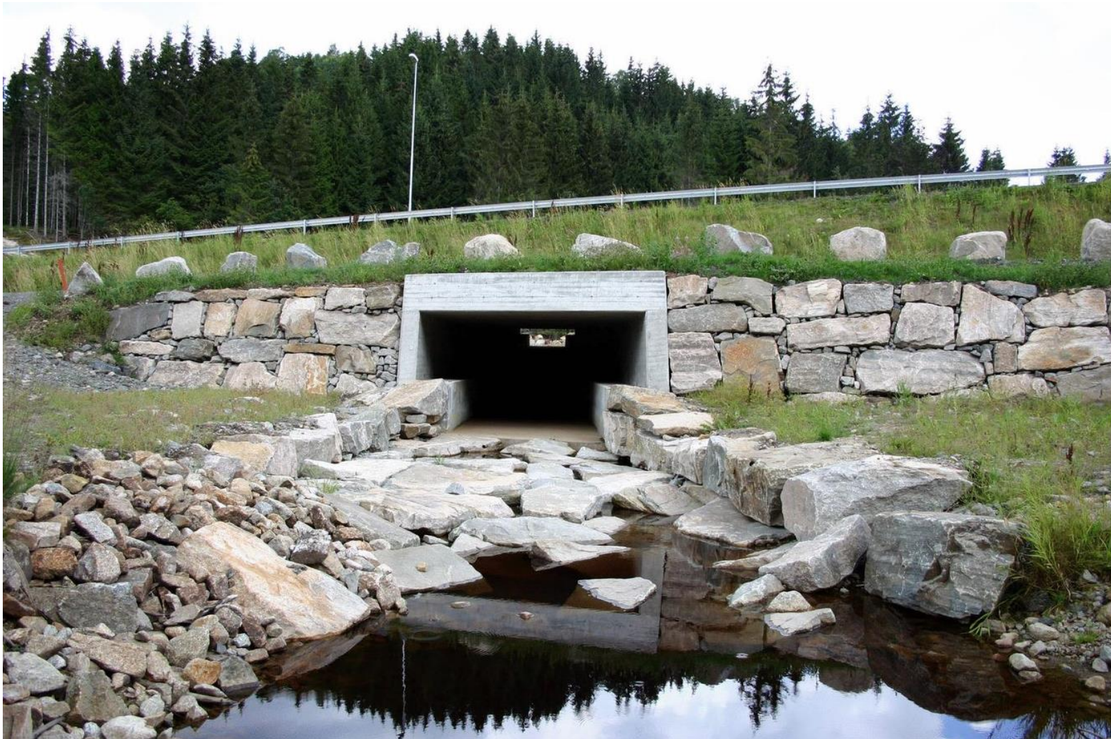
Figur 8-4: Utløp kulvert/bru veiprofil 6660 Botnebekken.
