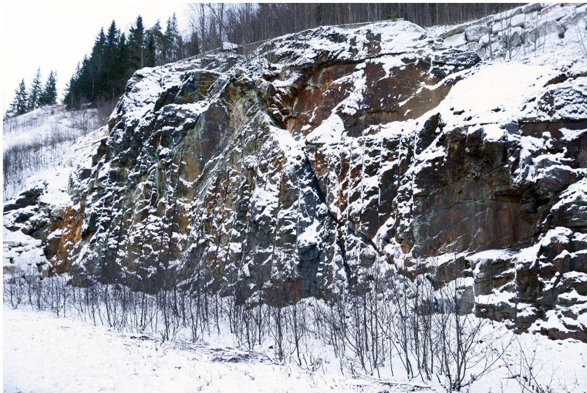
Bilde 5: Eksisterende skjæring i berg langs E6, vest for påhugg nord langs løp nr. 1. Grovblokkig bergmasse (0,5-1,0m 3 ), enkelte utfall.
