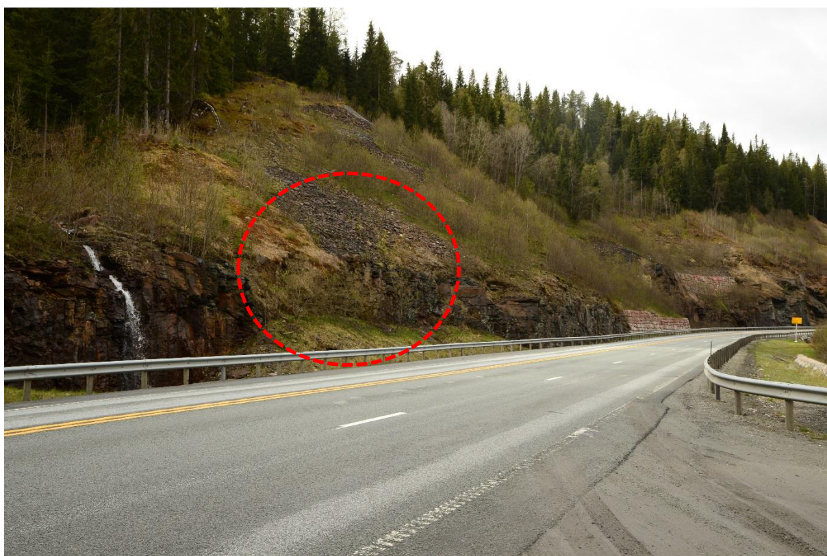
Bilde 4: Nordlige påhugg for løp nr. 1 er planlagt ved utvidelse av eksisterende skjæringer i berg langs E6, se område markert med rød ring. Bratt sideterreng dekket av plastringsmasser.
