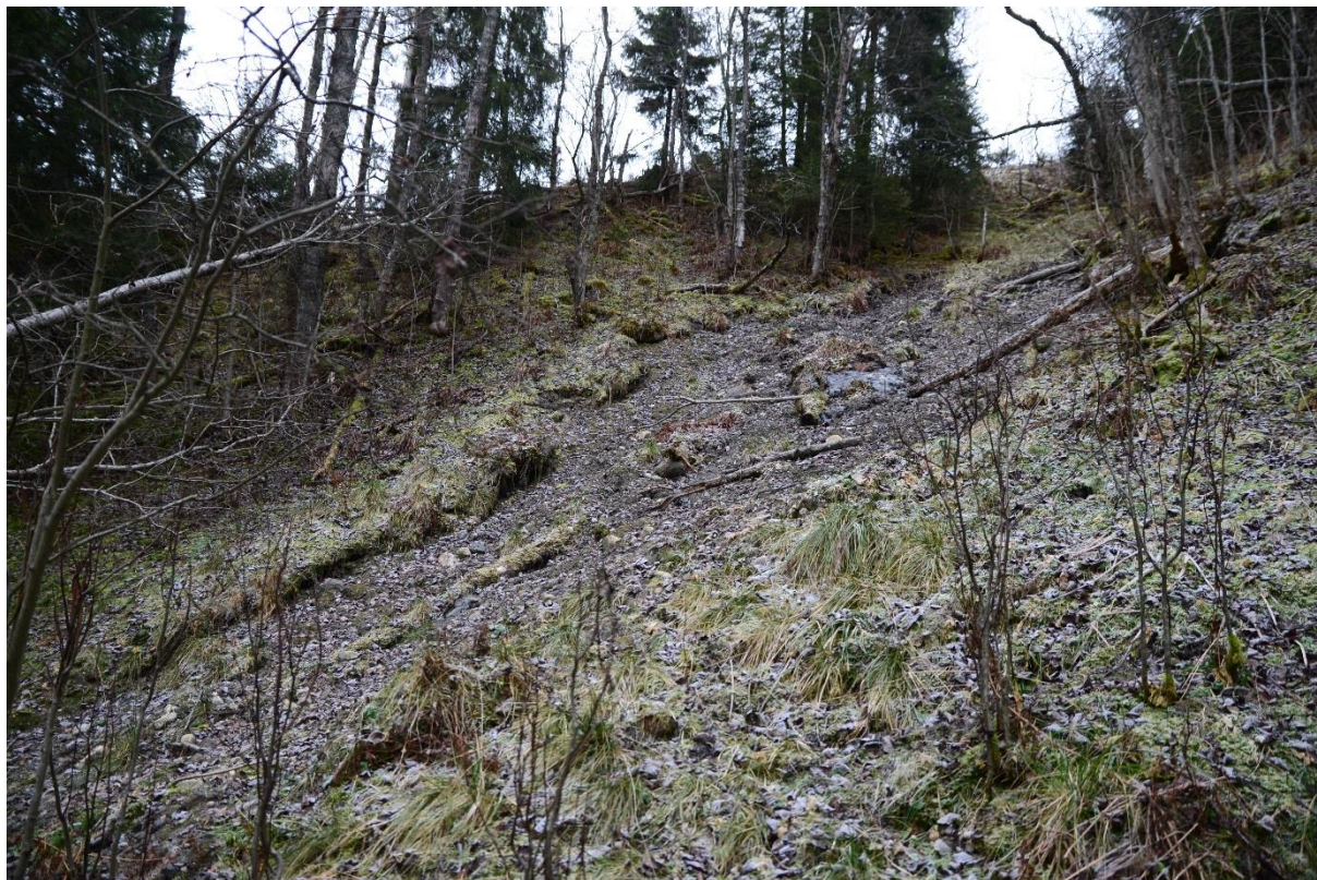
Bilde 3: Eldre løsmasseskred i sideterenget, ca. 20 meter øst for profil 24 850 langs løp nr. 1.
