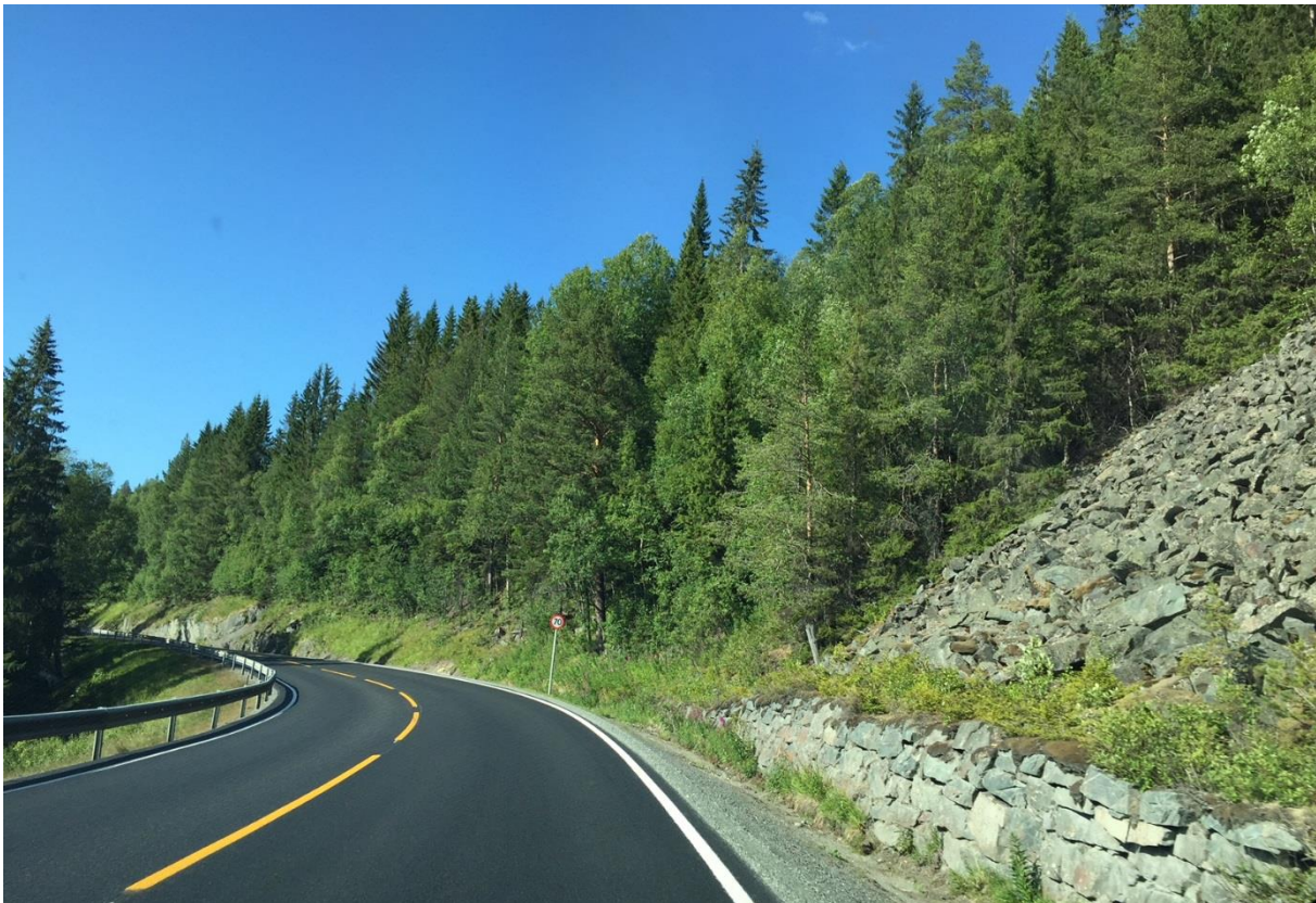
Del av E6 nord for Ulsberg i Rennebu kommune. Foto: Sweco 2018.
