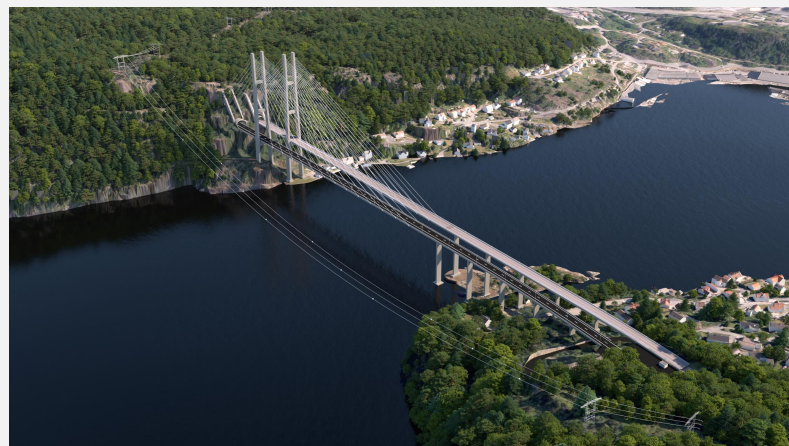
Oppstart bygging ny Grenlandsbru
