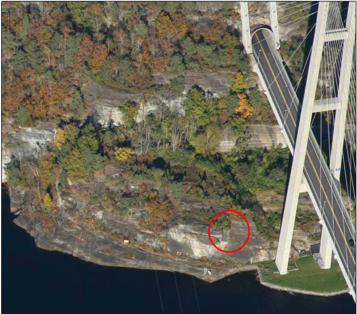
Figur 5-7 Skråfoto av nordre brutårn sett mot nord. Rød sirkel angir plassering av fundament.
