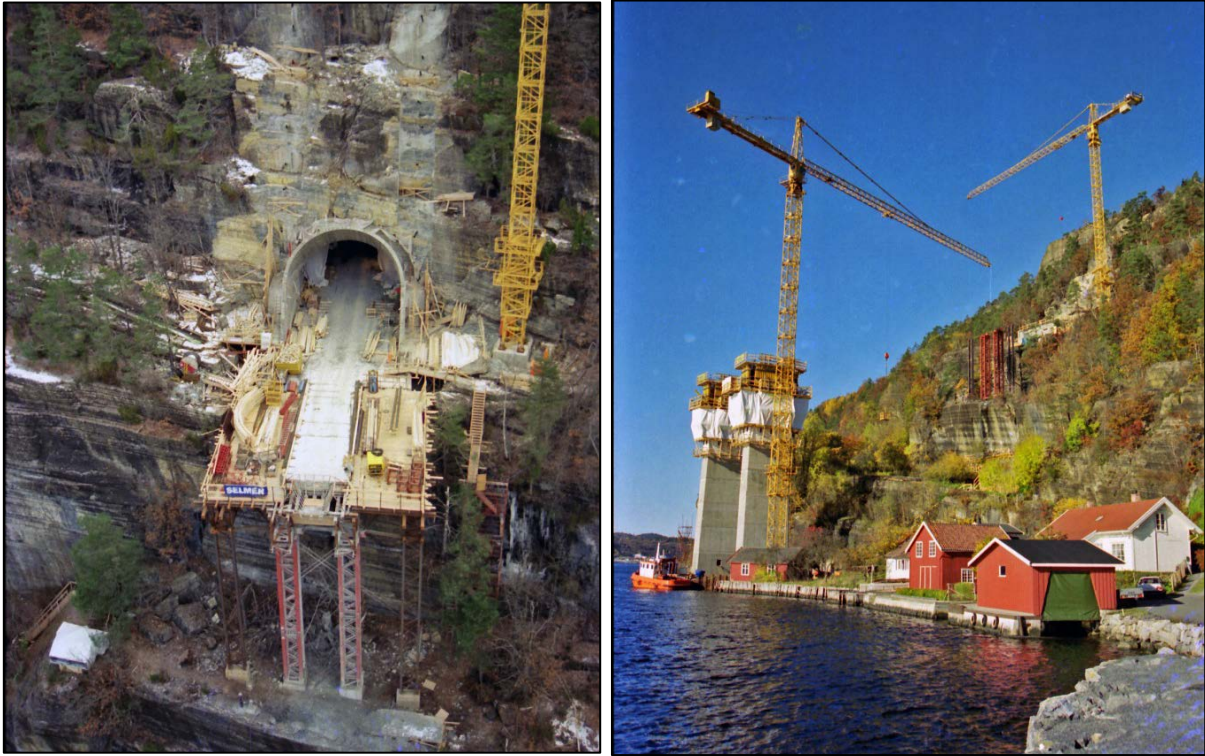
Figur 5-5 Bygging av eksisterende Grenlandsbru i 1994 (påhugget ved Frierflogene).
