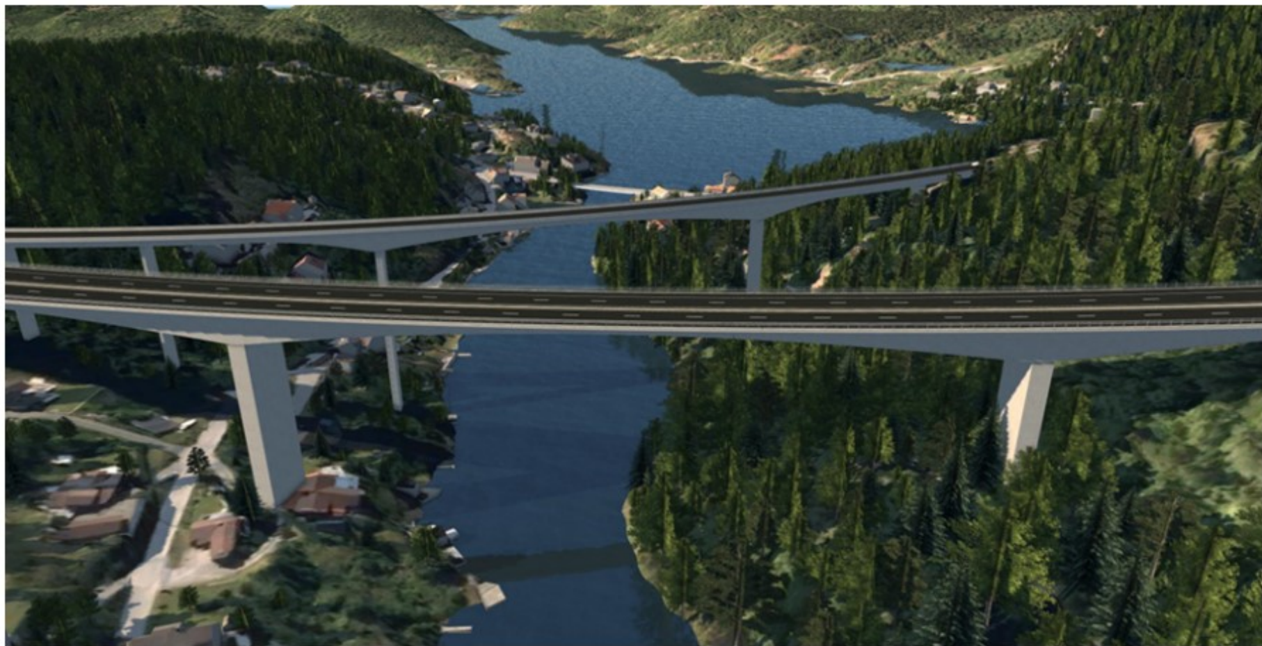
Figur 5-26 Langangen 1 bru, sett mot sør.
