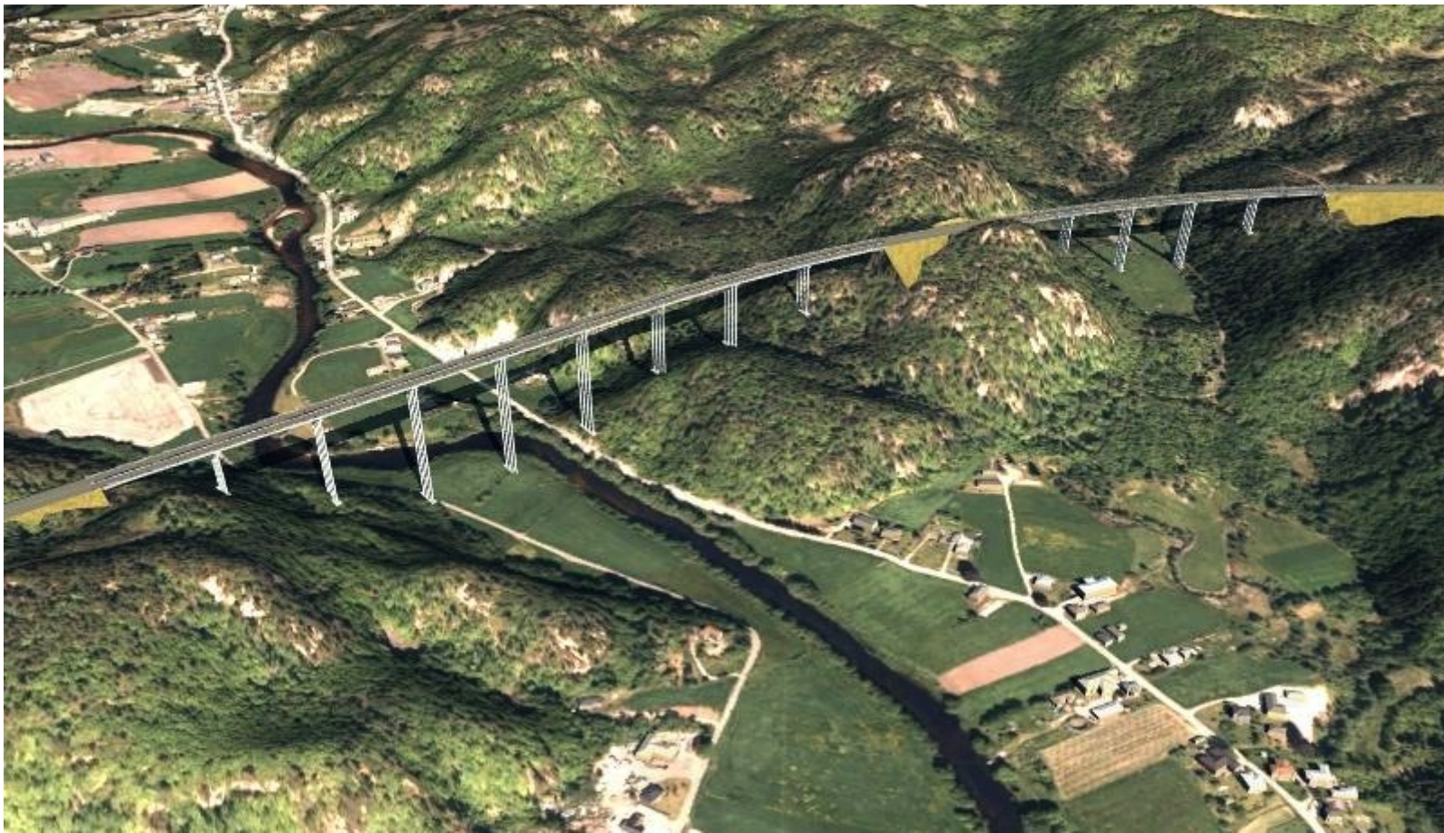
E39 Mandalselva – Lyngdal vest (Kontrakt C): Skofteland bru ved Audnaelva i Lindesnes. Blir Norges største seilingshøyde med klaring fra vannspeil til veibane på 135 meter.
