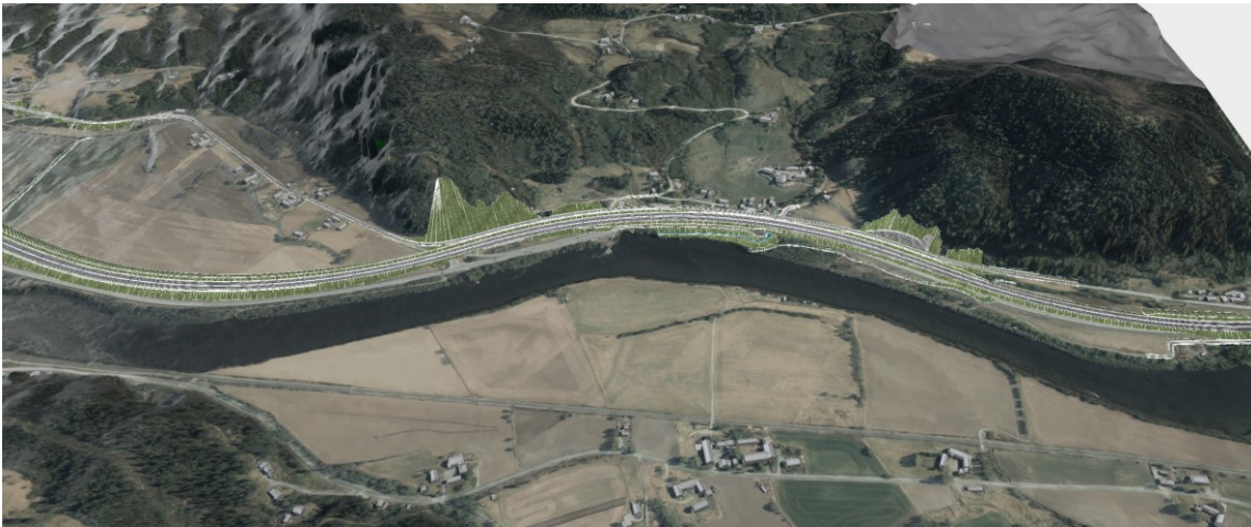
Figur 3-4 Veillinje fra Gyllan (til høyre) til Hovinkrysset med Vollasletta (til venstre). Kilde: Norconsult.
