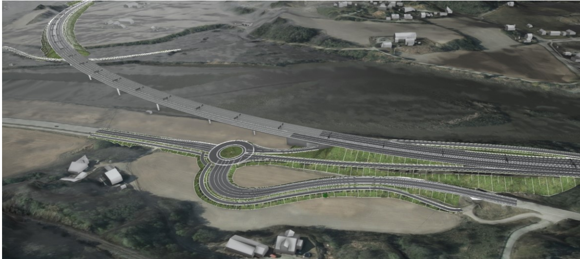
Figur 3-13 Bru ved Kåsa med halvkryss på østsida av Gaula, sett fra øst. Kilde: Norconsult.
