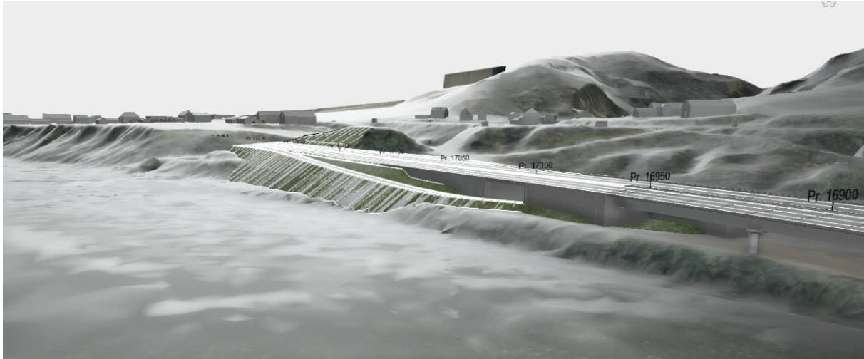
Figur 4-86 Elvesikring og fylling i Gaula ved nytt kryssområde ved Kvål. (Kilde: Norconsult)
