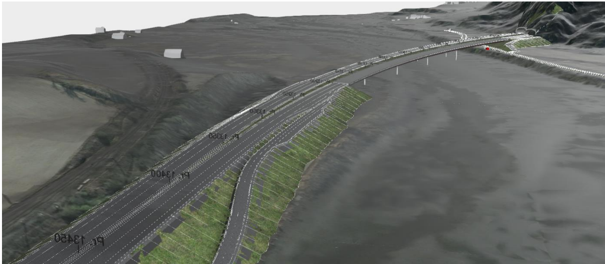
Figur 4-87 Brukryssing over Gaula ved Leberg. (Kilde: Norconsult)
