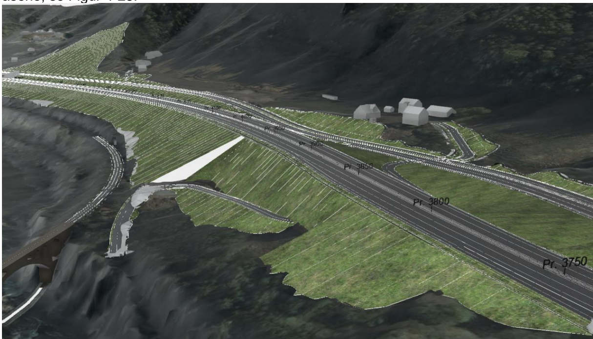
Figur 4-25 Nord for Horg bygdatun ligger ny E6 på høye fyllinger ned mot jernbanen. (Kilde: Norconsult)
