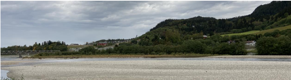
Figur 4-81 Fra vestsiden av Gaula, sett mot område for ny bru etter alternativ 2.1 med tilknytning til ny parsell i nord. Kvålsbrua til venstre i bildet. (Kilde: Norconsult)
