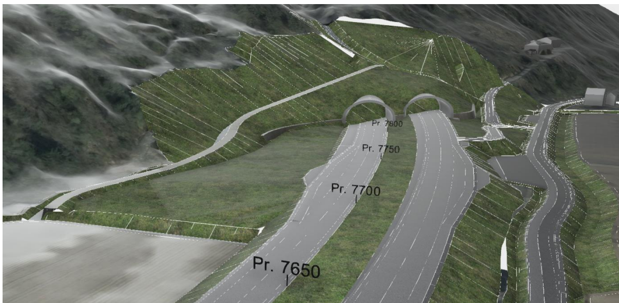
Figur 4-51 Alternativ 1.1/variant 1.2A Søndre portal på Homyrkamtunnel. Utforming bærer preg av rassikringstiltak som danner et unaturlig platå over tunnelportalen. (Kilde: Norconsult)
