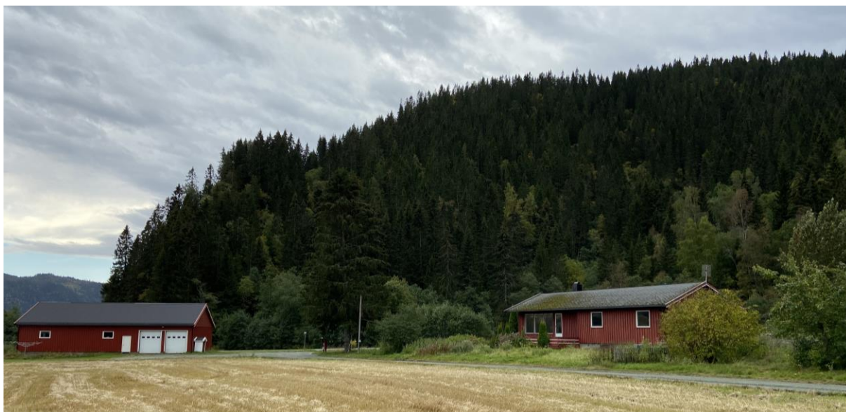
Figur 4-65 Fra området ved nordre påhugg for Homyrkamtunnelen etter alternativ 2.1. (Kilde: Norconsult)
