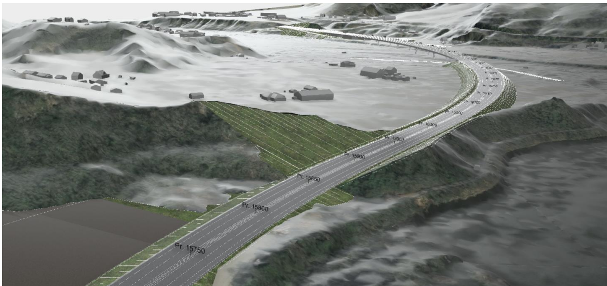
Figur 4-72 Skjæring ved Kåsa. Videre nordover mot Kvål ligger veianlegget på høye fyllinger. I nedre venstre hjørne vises områder der det er planlagt deponering av overskuddsmasser. (Kilde: Norconsult)
