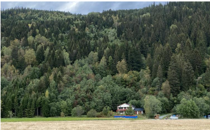
Figur 4-48 Fra Evjøyen ved søndre påhugg for Homyrkamtunnelen. (Kilde: Norconsult)
