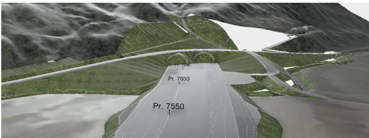
Figur 4-54 Søndre portal på Homyrkamtunnel. Lokalvei etter 1.2B går over portalene. (Kilde: Norconsult)
