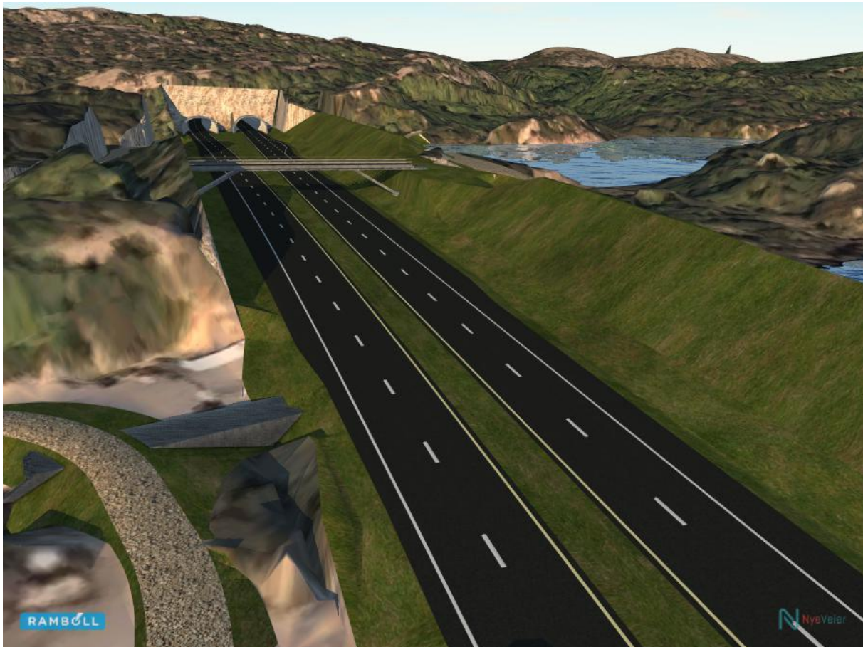
Figur 66: Støyvoller ved Fossvann sett mot Vågsbygdmarka.
