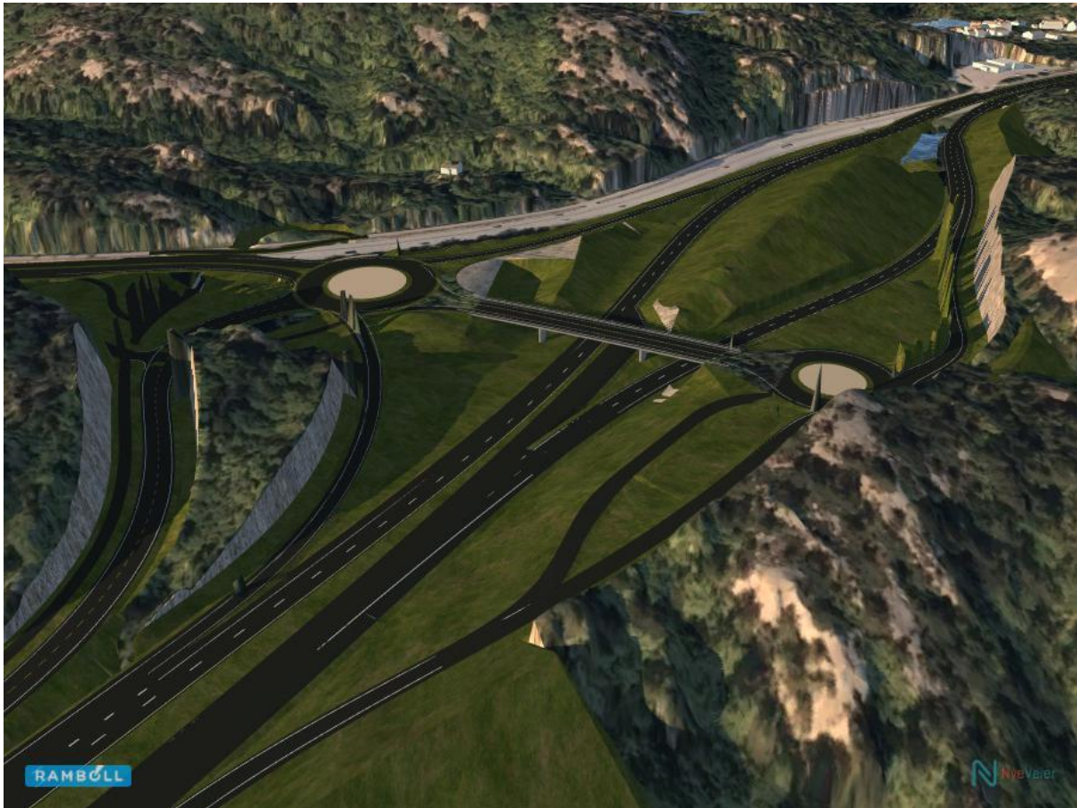
Figur 59: Krysset ved Grauthelleren sett mot nord (Rambøll 2017)
