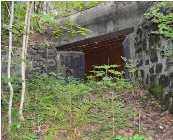
Figur 27: Ved Rossevang ligger denne Regelbau 620 bunkeren. (VAF 2016)
