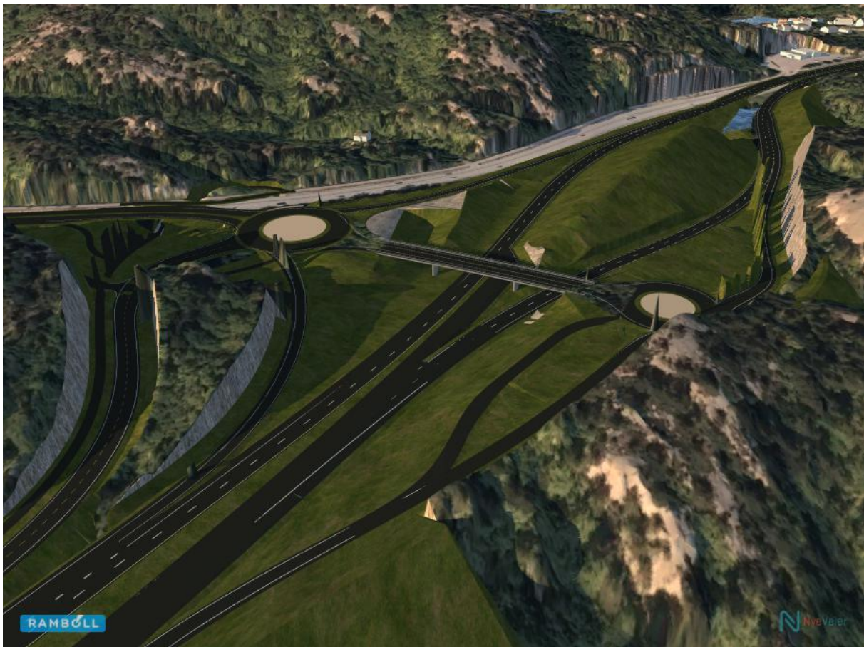
Figur 59: Krysset ved Grauthelleren sett mot nord (Rambøll 2017)
