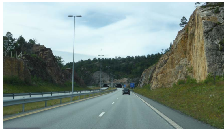
Fjellskjæringer tas normalt ut med helning 5:1 eller 10:1, men fjellets helning vil variere etter de gitte forhold. Se bilder ovenfor. Bildet er tatt på E18 mellom Grimstad og Kristiansand. Foto: Henrik Undeland.
