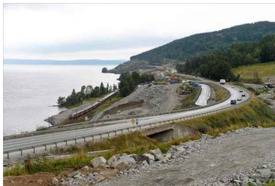
Fellesprosjektet for firefelts E6 og dobbeltspor på Dovrebanen Espa-Minnesund viser tydelig hvordan infrastrukturanlegg griper inn i landskapet og danner et nytt landskap. Midlertidige inngrep/sår i landskapet skal på sikt gli inn i landskapet dersom det har vært en bevisst tanke med utformingen av anlegget. Foto: Jens Erik Jensrud
