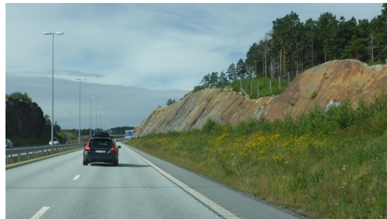
Fjellveggene langs en vei er viktig del av sideterrenget. Skråninger legges med helning for å minimere rekkverksbehov. Fjellskjæringer skal tilpasses bergets kvalitet og slippretning/helning. Bildet er tatt på E18 mellom Grimstad og Kristiansand. Foto: Henrik Undeland.
