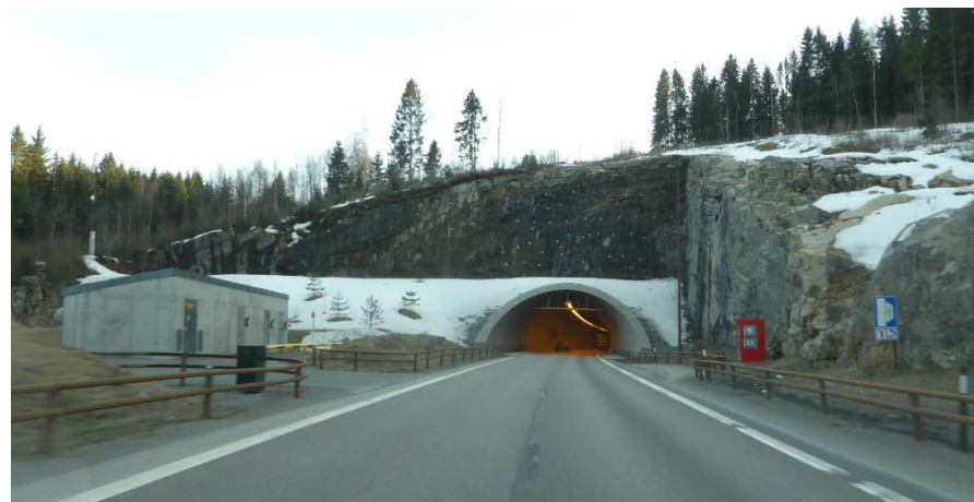
Bildet over viser eksempel på et teknisk bygg langs E6 ved Eidsvoll. Byggets materialer samsvarer med materialene som er brukt i tunnelportalene. Foto: Henrik Undeland.
