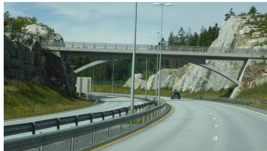
Utforming av bruer og veiutstyr påvirker trafikantopplevelsen og blir del av det nye landskapet i området. Bildet viser en situasjon med ulik type rekkverk i midtrabatt og sideterreng. Det skal etterstrebes et enhetlig, standardisert rekkverk. Bildet er fra E18 mellom Grimstad og Kristiansand. Foto: Henrik Undeland.
