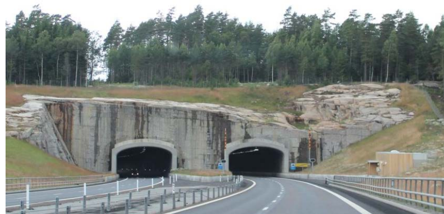
Bildet over viser eksempel på et teknisk bygg langs E6 ved Tanum. Bygget er kledd med tre (Eik) som gjør at bygget glir godt inn i veiens sideterreng i tillegg til at det er plassert i en nisje og synes derfor nesten ikke i det heletatt. Foto: Katharina Nyström
