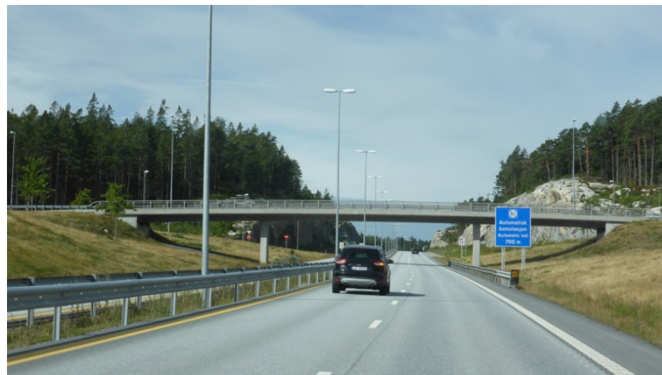
Eksempel på enkel utformet overgangsbru. Terrenget flyter igjennom. Ved ønske om kortere overgangsbruer vil det være ekstra viktig å formgi terrenget under bruene over et lengre strekk, slik at ikke disse punktene blir visuelle «innsnevring» langs linja. Bilde tatt langs E18 mellom Grimstad og Kristiansand. Foto: Henrik Undeland
