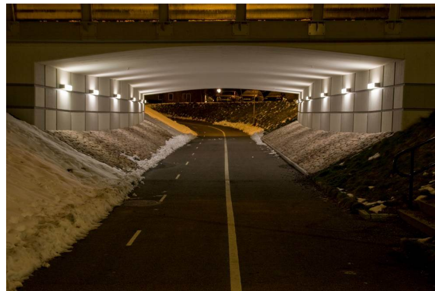
Eksempel på belysning i undergang for myke trafikanter under en trafikkert vei i Kortedala i Göteborg. Foto: Henrik Undeland
