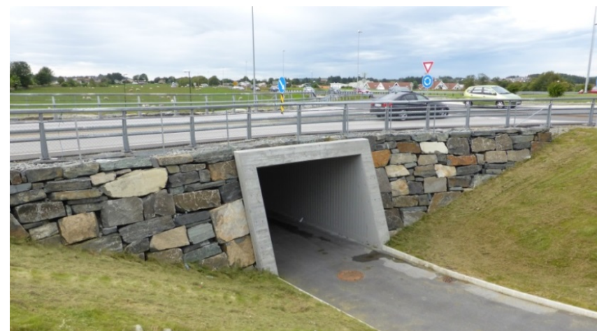
Underganger for myke trafikanter krever høyere grad av detaljering og omtanke for detaljer. Nærhet til den menneskelige skala samt hensyn til opplevelse av sikkerhet og sosial kontroll er viktige premissgivere for design og formgivning. Fra Randaberg ved Stavanger. Foto: Henrik Undeland
