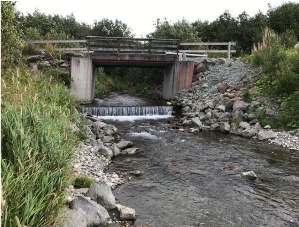
Figur 2-7. Bru i nederste del av Kaldvella har medført et sprang som trolig virker som temporært vandringshinder for oppvandrende gytemoden sjørret. Foto: Torstein Rognes, Gaula Fiskeforvaltning.
